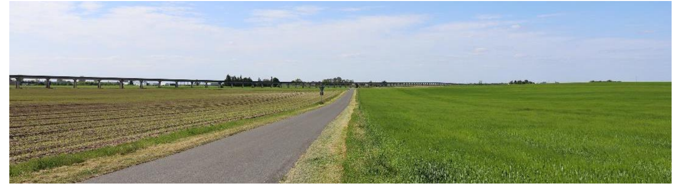
Figure 158 : La forêt d'Orléans – En lisière, le regard porte au loin mais les perceptions restent filtrées par les nombreuses infrastructures Source : AEPE Gingko
