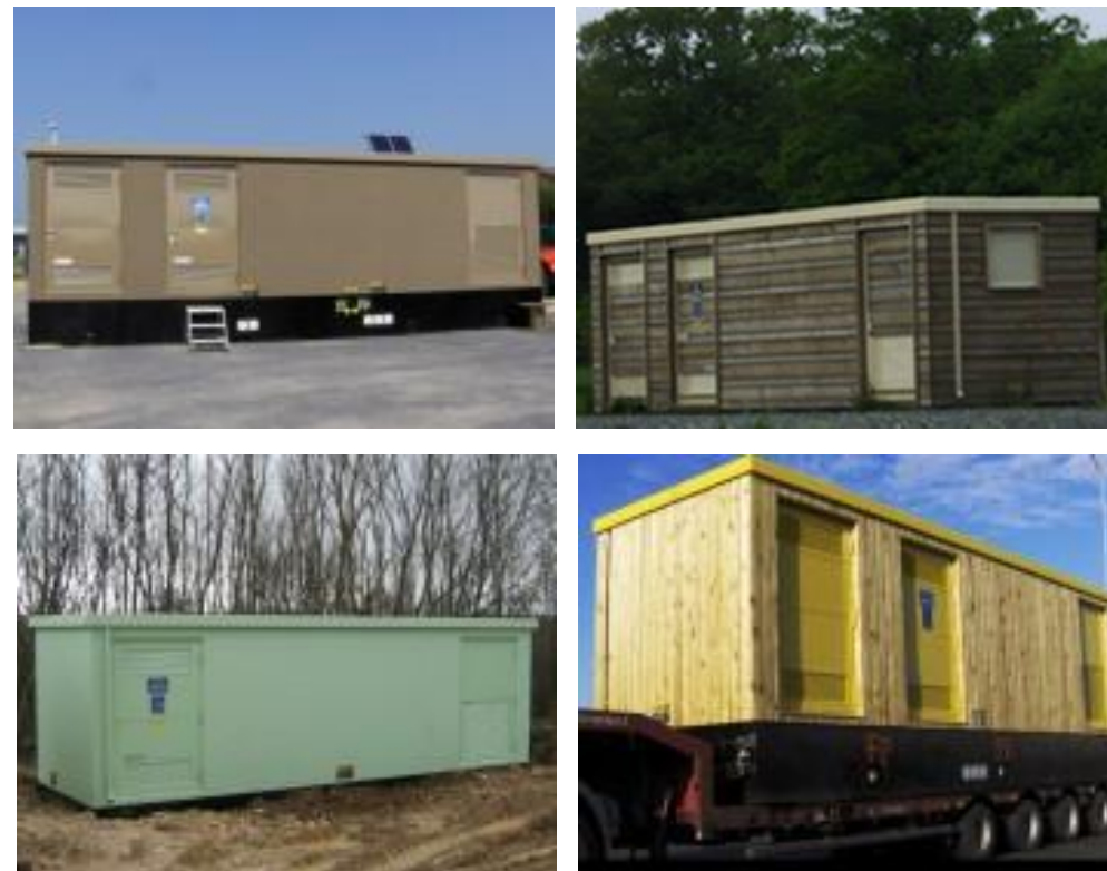
Figure 49 : Exemples d'habillages de postes de livraison
