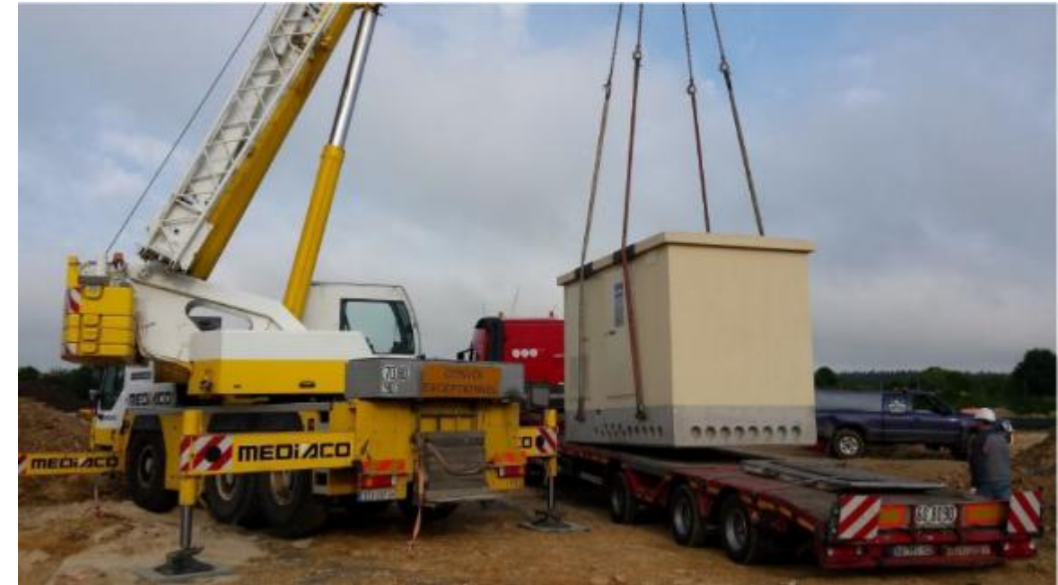
Figure 59 : Grutage d'un poste de livraison 20kV Source : SHIPELEC – http://www.shipelec.fr/electricite-haute-tension#!prettyPhoto/pp_gall/3/
