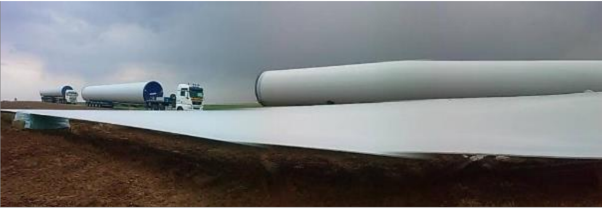
Figure 55 : Stockage temporaire de composants d'éolienne Source : Vestas - Etude d'impact sur la Santé et l'Environnement – 3.0 to 4.2MW Platform – 2017-12-26
