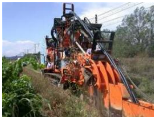
Figure 58 : Engin utilisé pour le creusement des tranchées (trancheuse) Source : Vestas - Etude d'impact sur la Santé et l'Environnement – 3.0 to 4.2MW Platform – 2017-12-26
