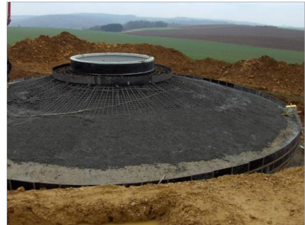
Figure 57 : Ferrailage de la fondation et coulage du béton
