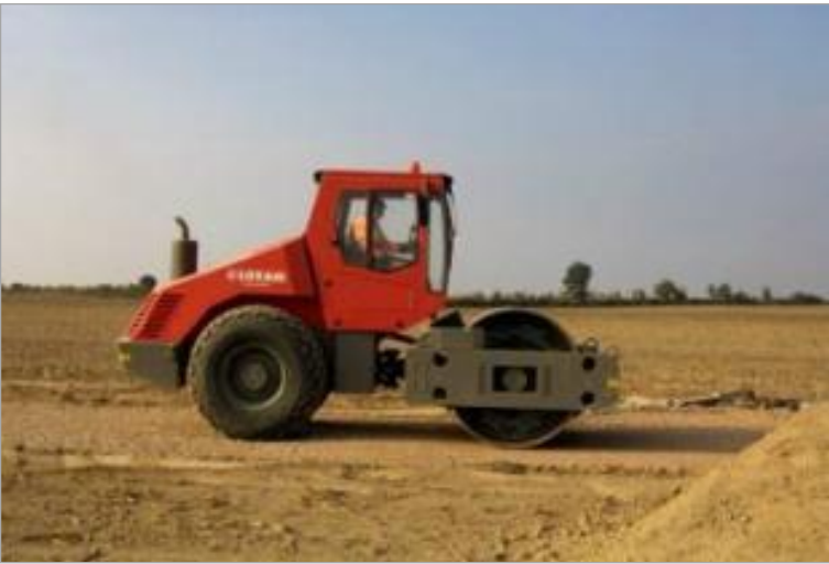
Figure 53 : Aplanissement du terrain Source : Vestas - Etude d’impact sur la Santé et l’Environnement – 3.0 to 4.2MW Platform – 2017-12-26
