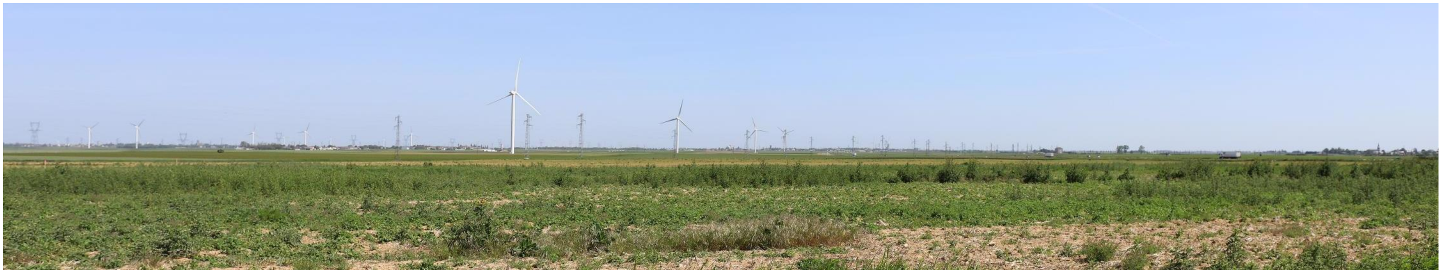
Photo 4 : Perception de l'ensemble des parcs éoliens situés sur les communes de Santilly, Tivernon, Poinville et Janville depuis l'est de Santilly via la RD355.1
