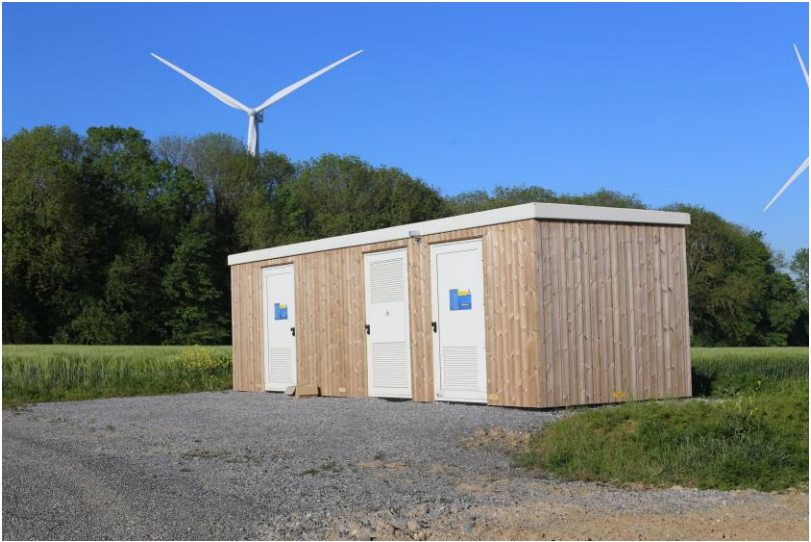
Photo 61 : Exemple d'un poste de livraison avec platelage bois
