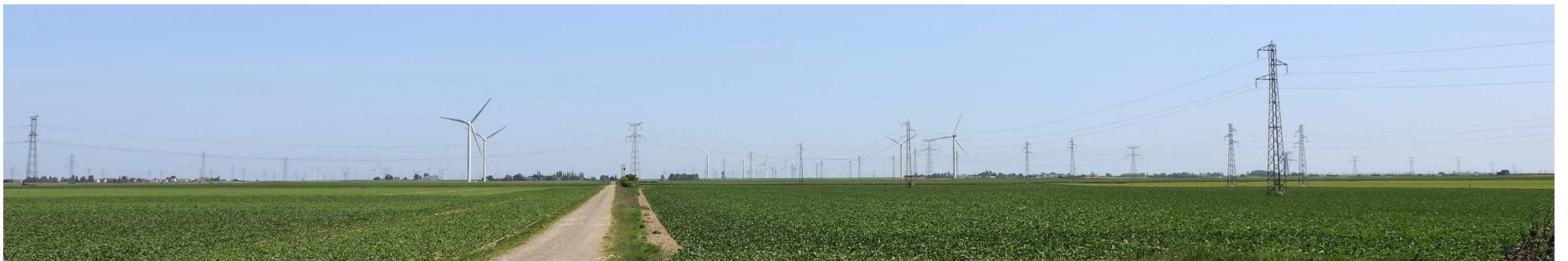
Photo 2 : Perception de l'ensemble des parcs éoliens situés sur les communes de Santilly, Tivernon, Poinville et Janville depuis l'est de Dambron via la RD 355.7
