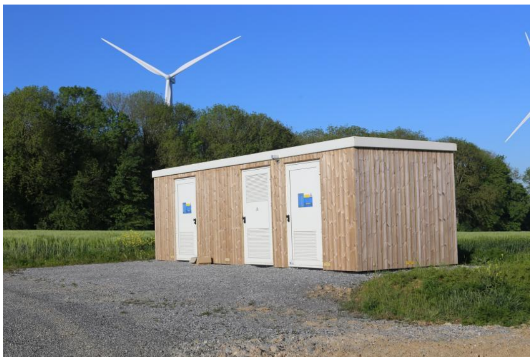
Figure 9 : Exemple d'un poste de livraison avec un bardage bois
