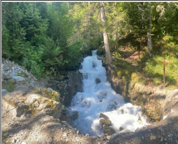
Photographie A : Prise d'eau de Montgellaz
