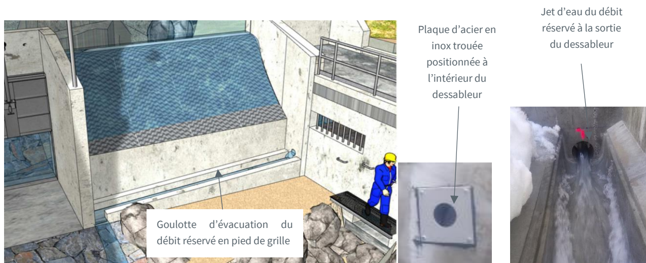
Restitution du débit réservé. Prise d'eau de Montgellaz.
