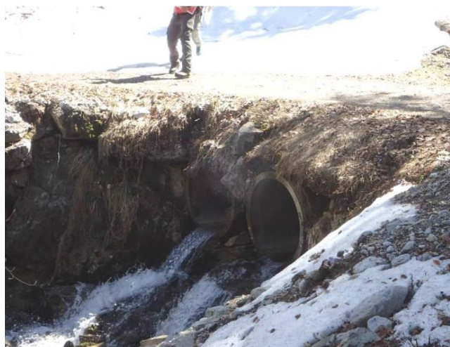
Figure 64 : Passage busé sous la piste de ski de fond (Source : SIGosphère)
