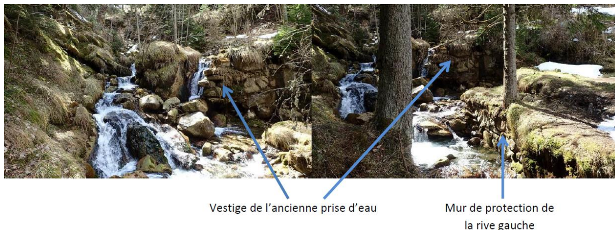
Figure 65 : Photographie de l'ancienne prise d'eau du ruisseau des Gravelles, au lieu-dit « le Moulin » (Source : SIGosphère)
