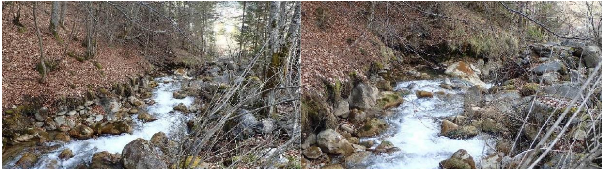
Figure 74 : Photographies des érosions de berge de rive gauche sur le torrent de la Rosière (Source : SIGosphère)
