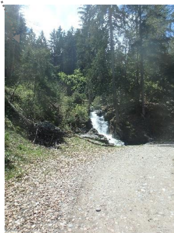
Chemin utilisé pour la mise en place de la conduite forcée (ruisseau de Montgellaz)
