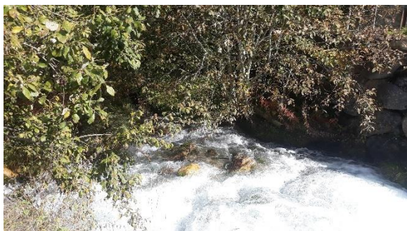
Photographie 3 : Dérivation canal en rive droite
