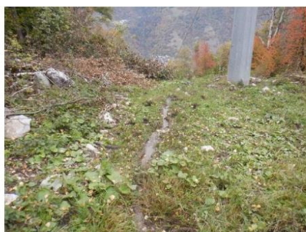
Écoulement au droit du sondage T15
