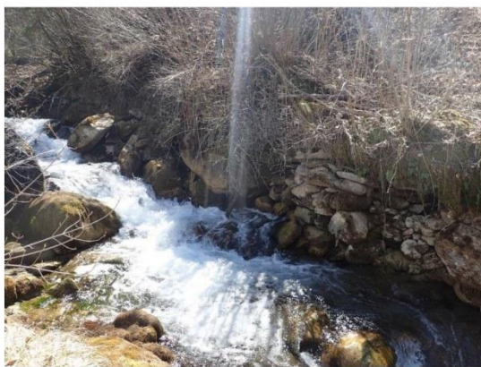
Figure 14 : Erosion de la rive gauche du torrent de la Rosière Source : SIGosphère
