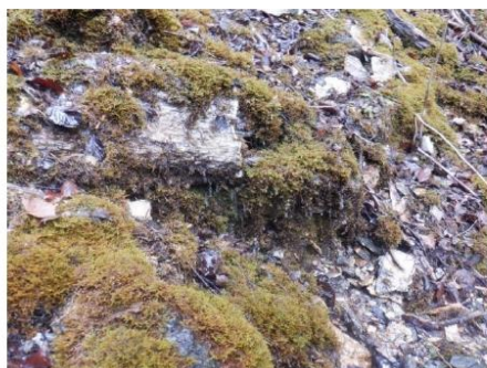
Écoulement au droit du sondage T1
