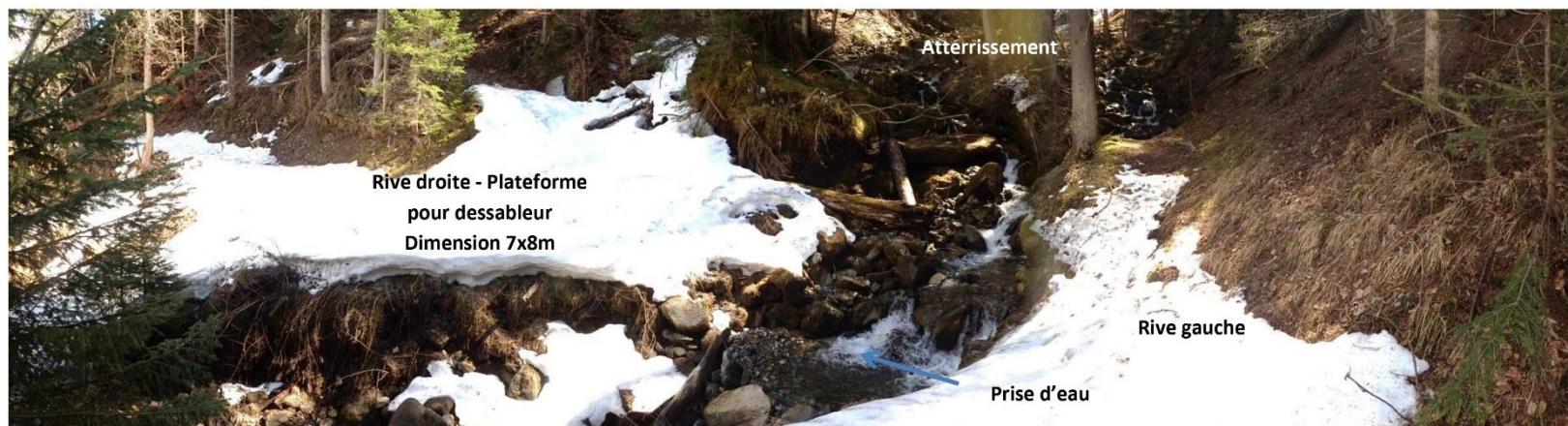
Figure 4 : Photographie du secteur, vue vers l'amont Source : SIGosphère
