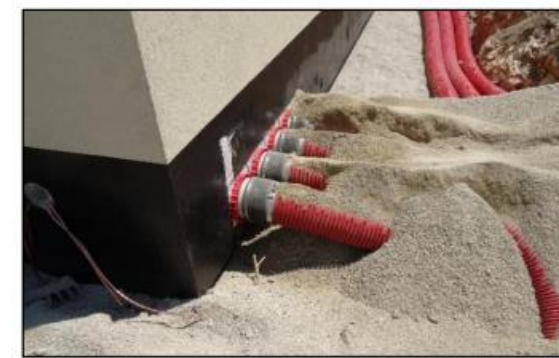
Installation d'un poste électrique (Source : TENERGIE)
