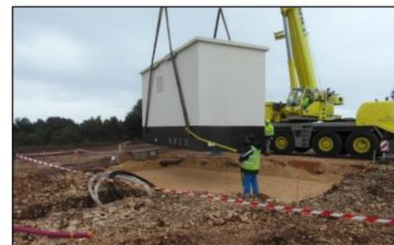
Installation d'un poste électrique (Source : TENERGIE)
