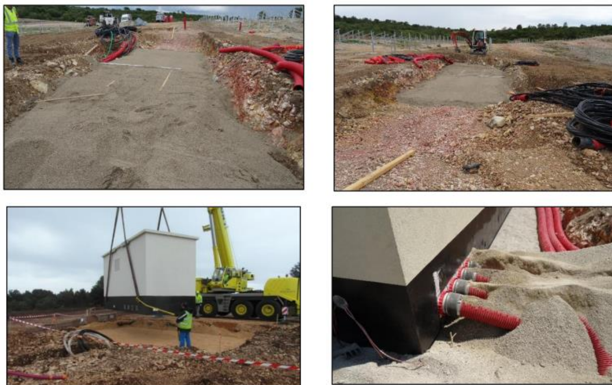
Figure 25 : Illustration de l'installation d'un poste électrique par grutage (source : Tenergie)
