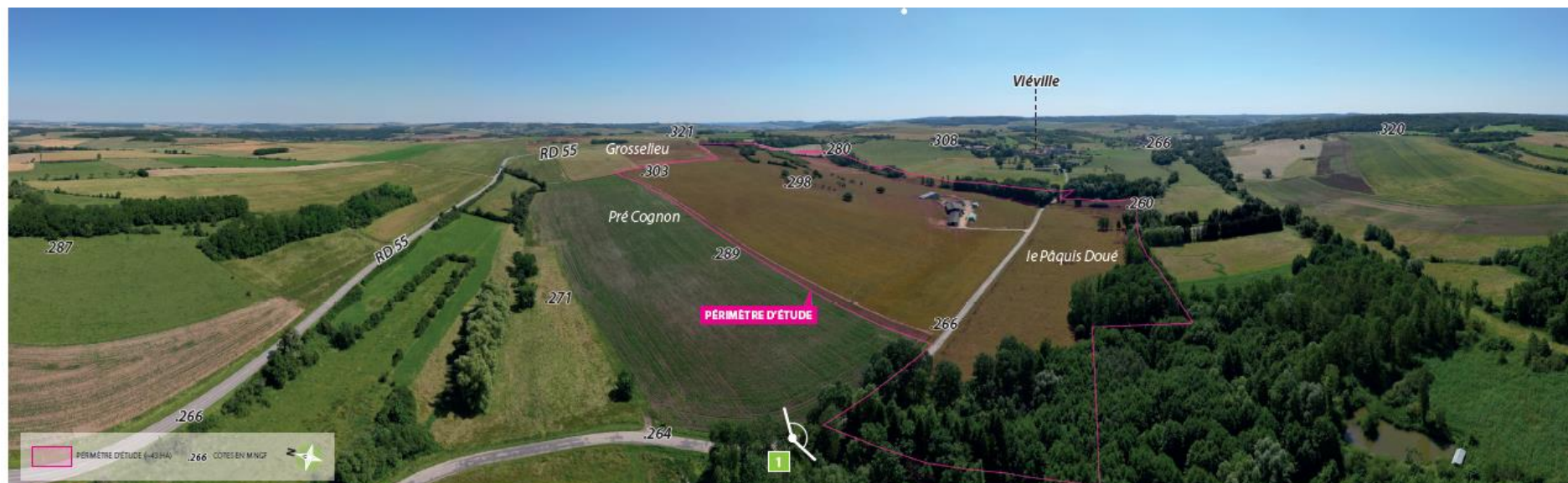
Figure 122 : Vue aérienne de drone du périmètre/zone d'étude direction Sud-Est (Source : Composite, 2025)
