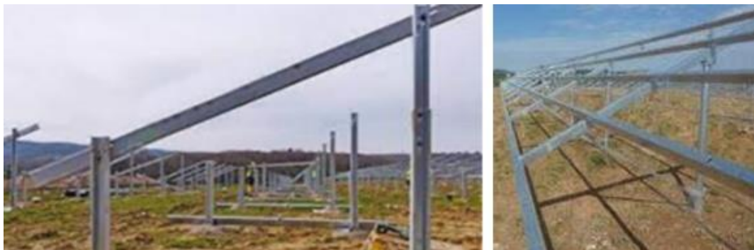
Figure 23 : Exemple de montage des supports pour accueillir des modules photovoltaïques
