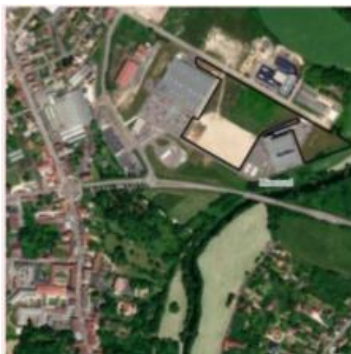
Figure 33 : Site de Mirecourt artificiel étudié (source : TENERGIE)
