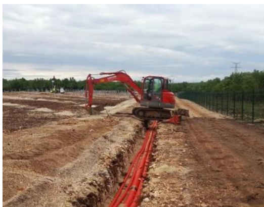
Figure 24 : Exemple de tranchées pour enfouissement des câbles (source : Tenergie)
