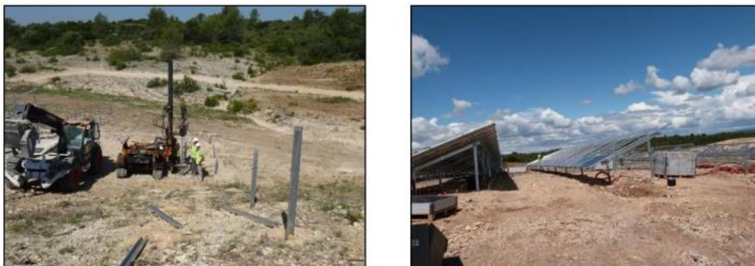
Figure 22 : Mise en place des structures porteuses et des panneaux (source : Tenergie)
