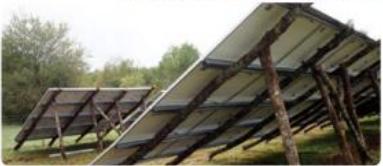
Exemple de structure porteuse en bois local à Carayac (46) © Energie-partagee.org
