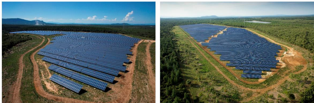
Figure 7 : Exemple de la centrale solaire de Belvesol dans le Gard (20 MWc) (source : Tenergy)
