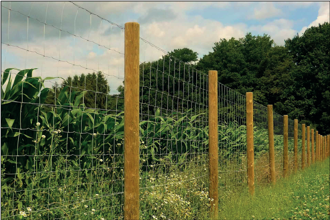
Clôture composée de piquets bois et d'un grillage souple - hauteur : 2m passages pour la petite faune (20x20cm) en partie basse
