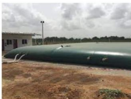
Stockage de fluides pour chantier
