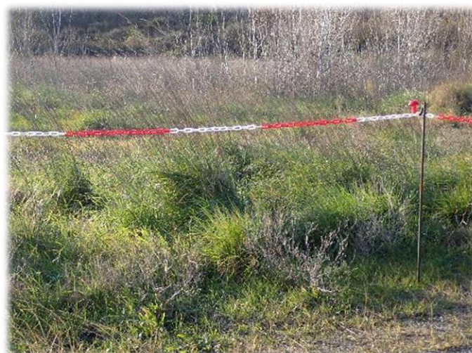
Photo 39 : Piquets porte-lanternes en métal avec chaînettes en plastique colorées (Source : Ecosphère)
