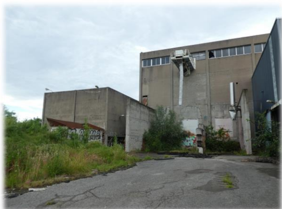
Photo 13 : Bâtiments en friche et enrobé
