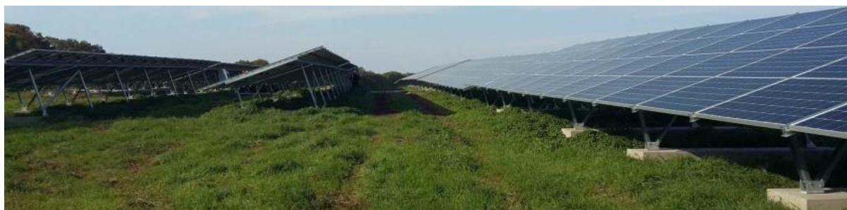
Photo 35 : Exemple de vue de structures utilisant des fondations bétons ou longrines (Source : TSE)
