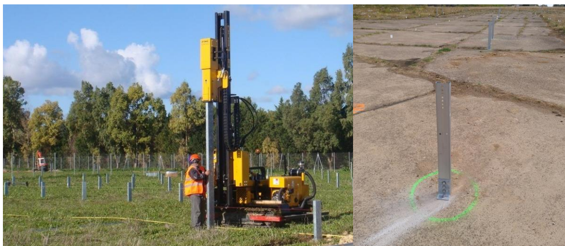
Photo 34 : Sonnette de battage hydraulique (gauche) et fixation mécanique sur dalle (droite) (Source : TSE)
