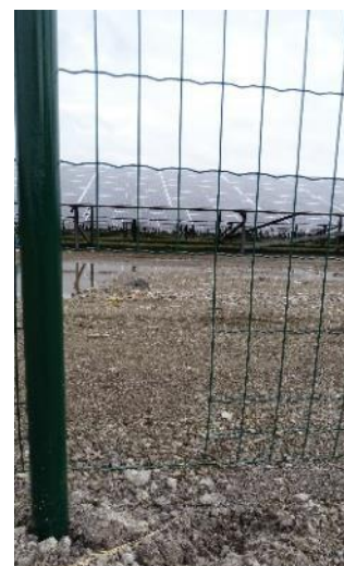
Photo 42 : passage à petite faune intégré à la clôture Source : TSE
