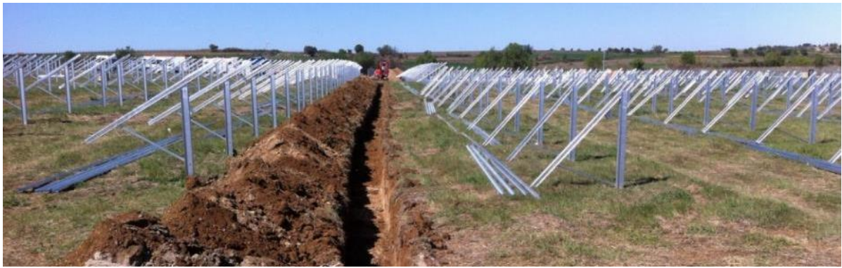
Photo 33 : Exemple de tranchée (Source : TSE)
