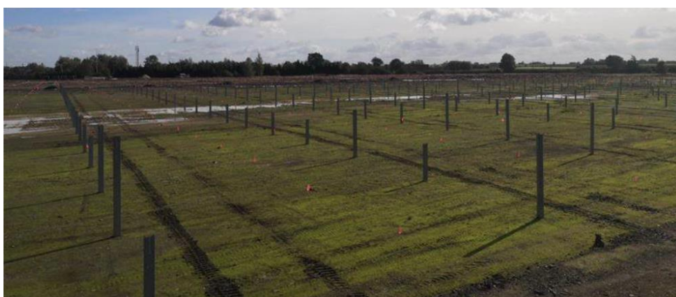
Photo 31 : Passage unique d'engin à l'avancement pour battage. (Source : TSE)
