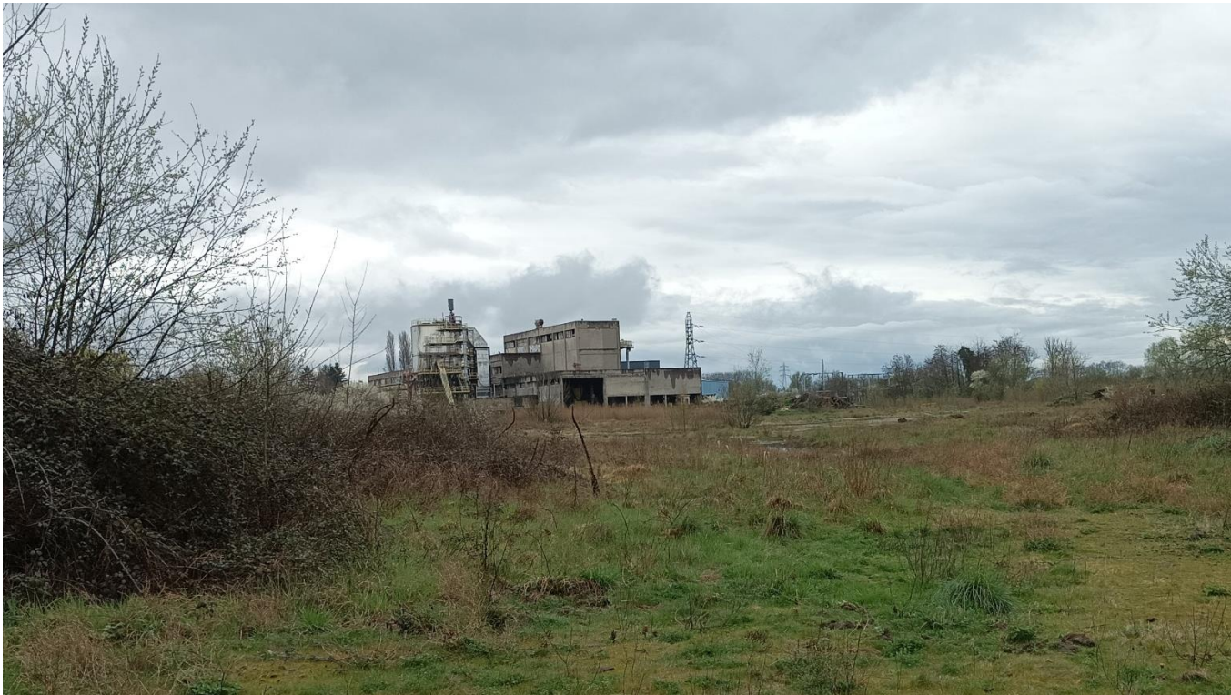
Photo 3 : Vue sur le site sur la commune de Saint-Usage (21)
