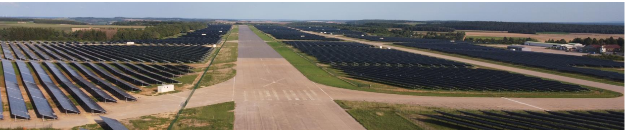
Figure 8 : Centrale photovoltaïque vue du ciel
