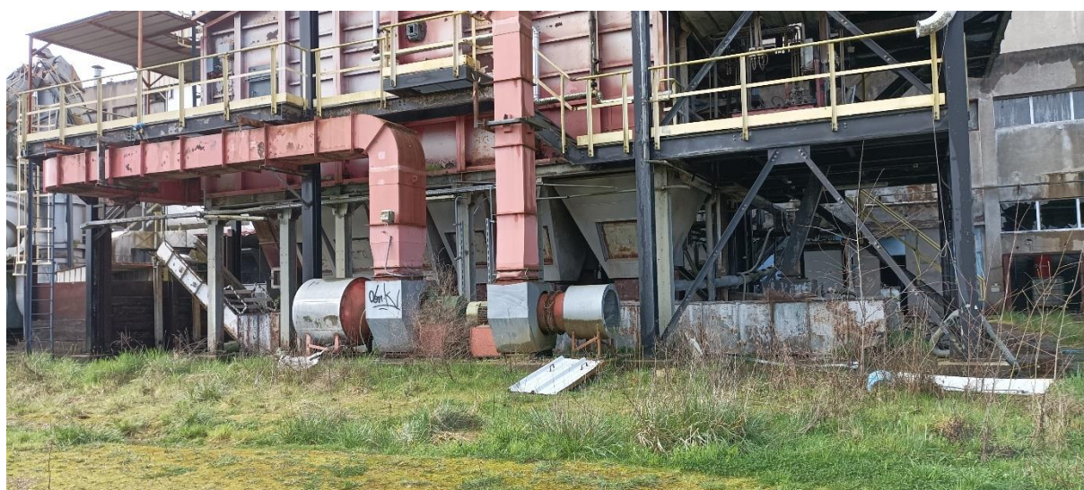
Usine désaffectée, cuves
