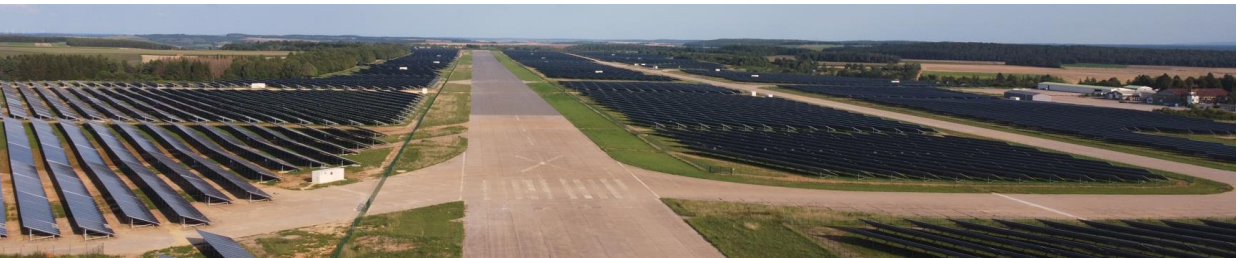
Figure 8 : Centrale photovoltaïque vue du ciel
