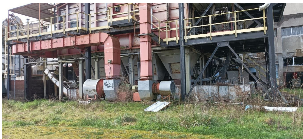
Photo 3 : Usine désaffectée, cuves et autres installations
