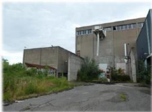
Photo 13 : Bâtiments en friche et enrobé
