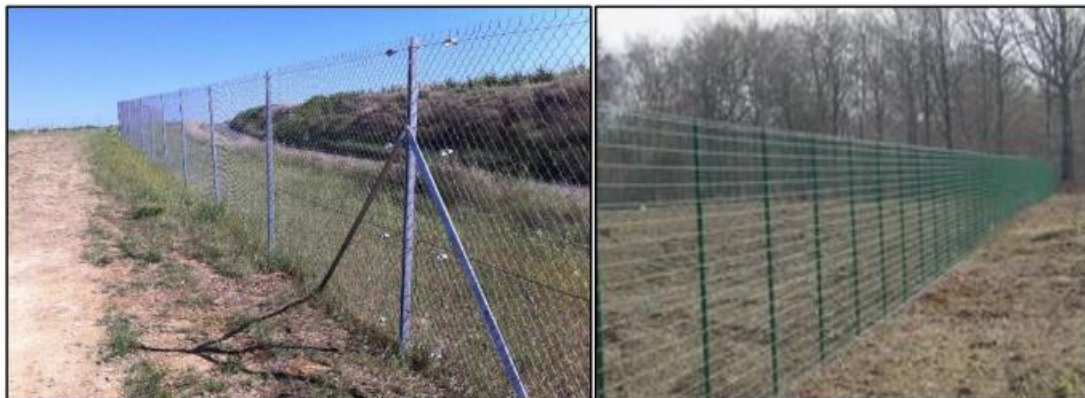
Figure 10 : Exemple de clôtures (source : TSE)
