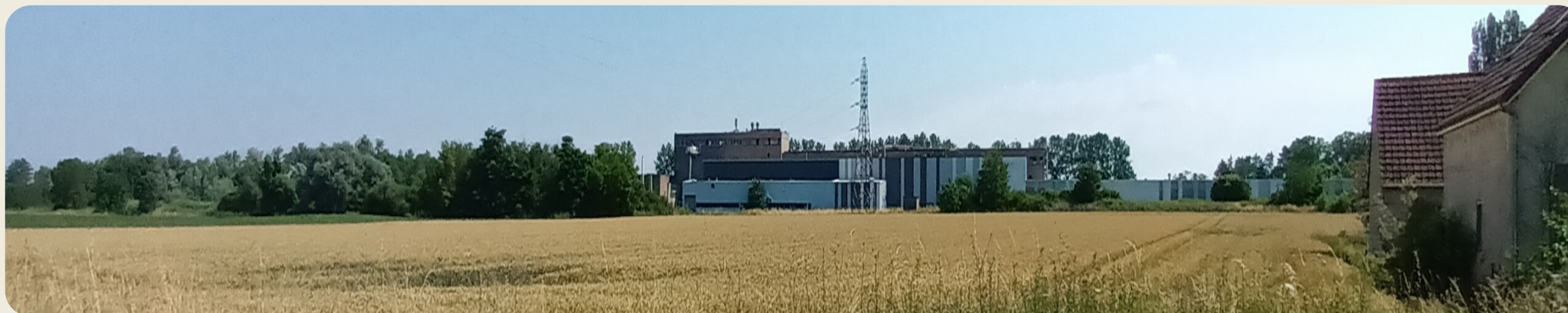
Vue de l'existant
