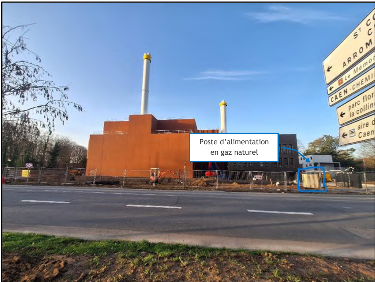
Figure 7. Poste d'alimentation en gaz naturel (source : CORIANCE)
