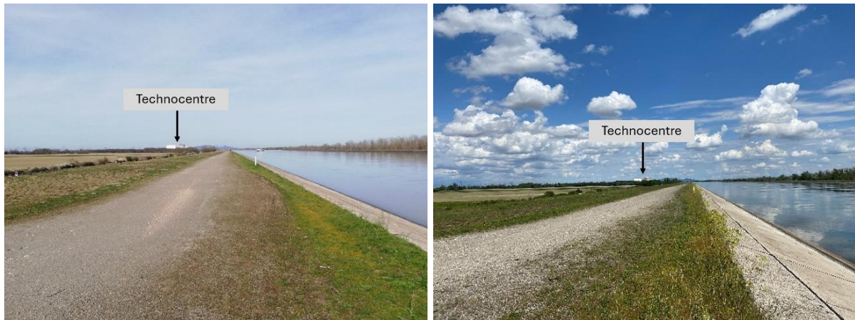
Figure 9.m : Vues depuis la rive ouest du Grand Canal d'Alsace en hiver (à gauche) et au printemps (à droite) (Source : Eranthis)
