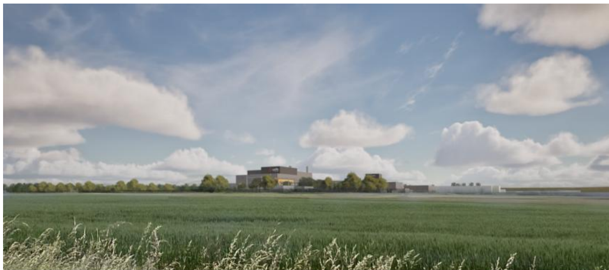
Figure o : Vue sur le Technocentre depuis la RD468 (source Eranthis)
