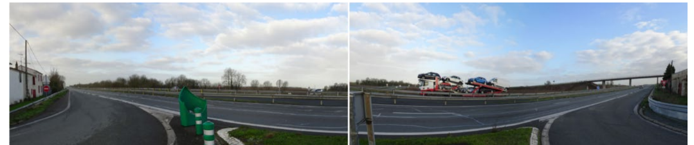
Vue tronquée par les talus, en bordure de la RN11 (Source : Agence Couasnon)
