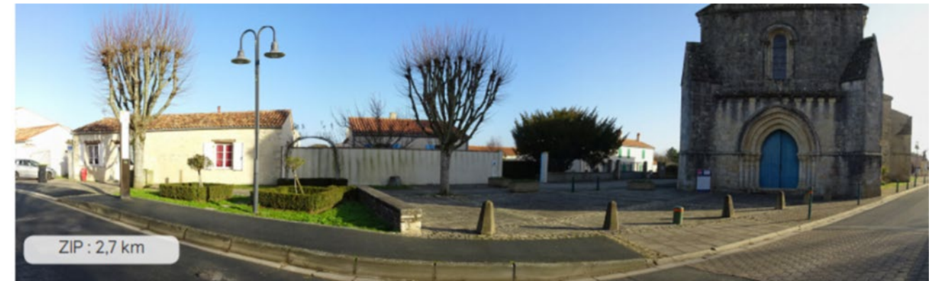
Eglise Saint-Laurent (Source : Agence Couasnon)
