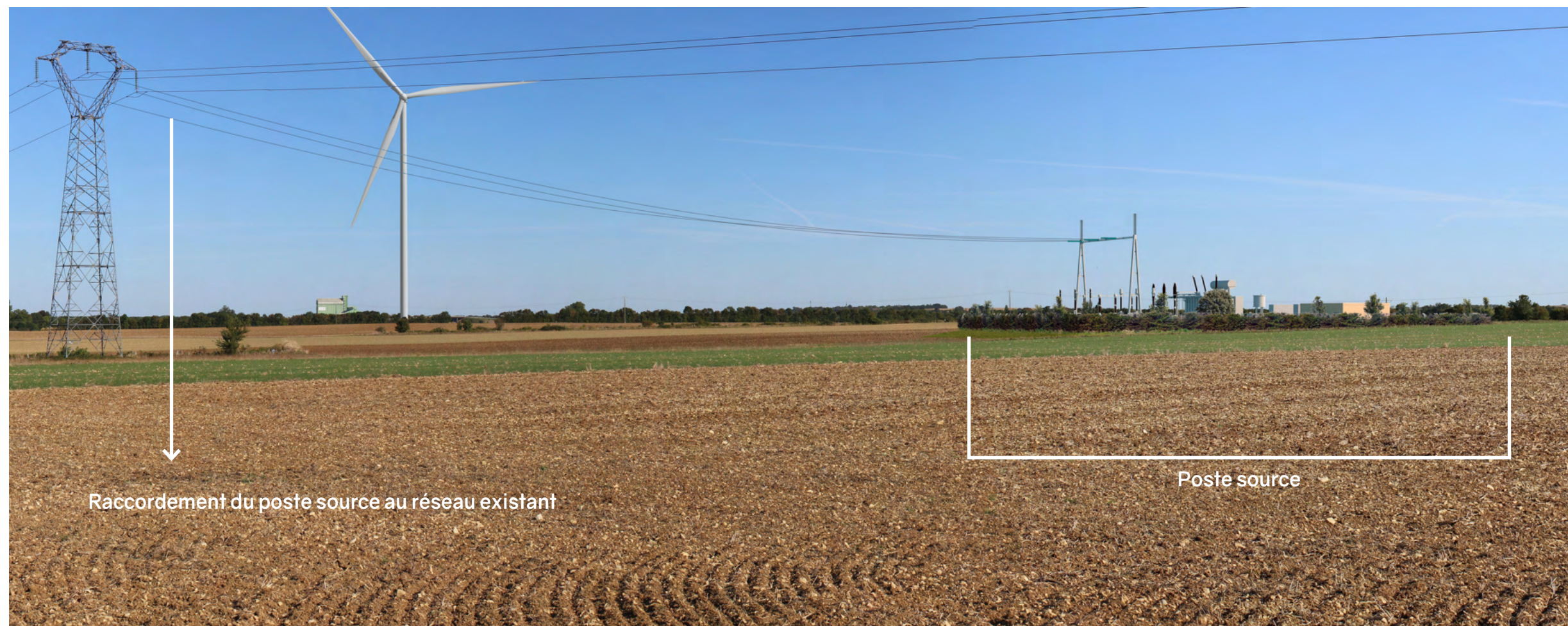
Photo 178 : Zoom de sur le poste source
