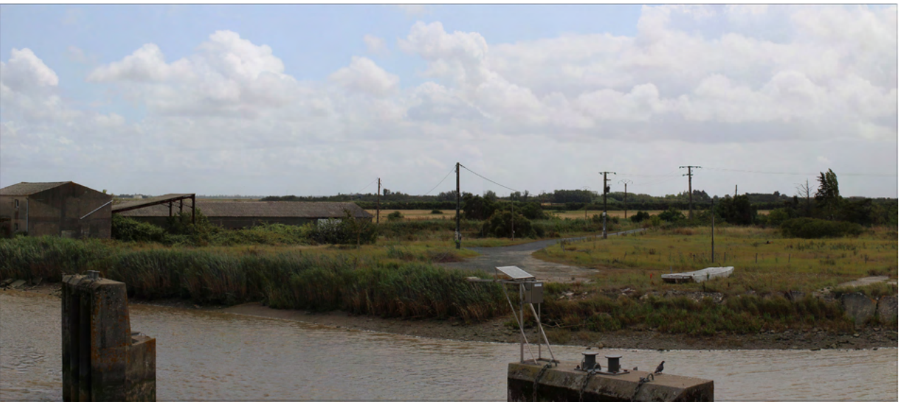
Photographie de l'état initial à 50°
