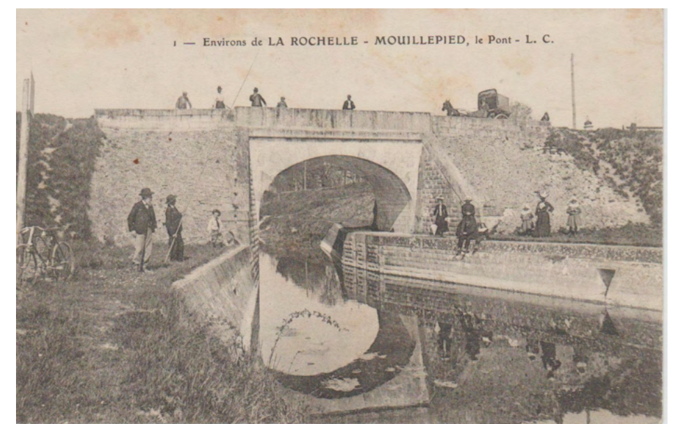
Photo 107 : Carte postale du pont de Mouillepied et du canal de Marans
