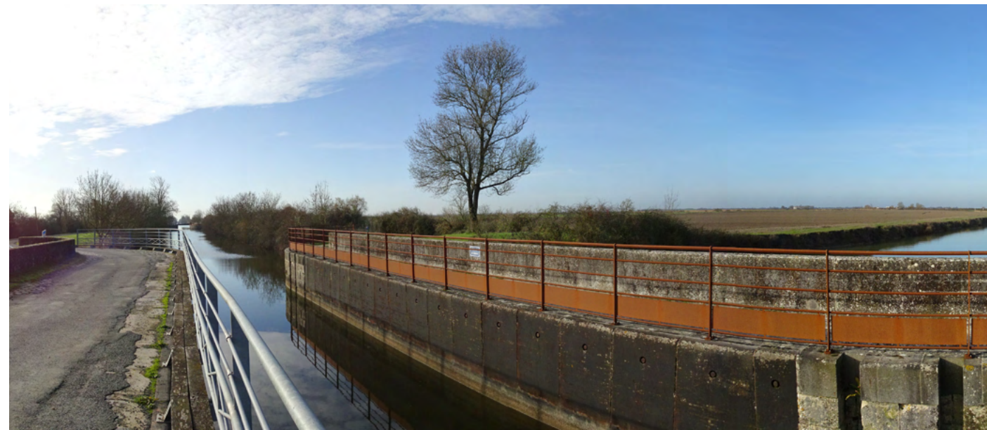
Photo 118 : Depuis le canal de Marans à La Rochelle les perceptions visuelles sont réduites et cadrées par la végétation qui borde l'infrastructure hydraulique en direction du site d'implantation potentiel
