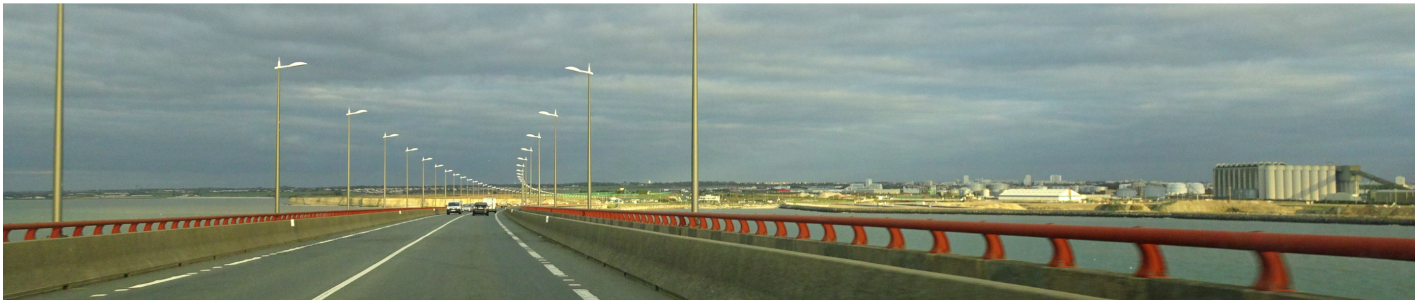
Photo 50 : Vue tronquée par les constructions sur le continent en direction du projet depuis le pont de Ré
