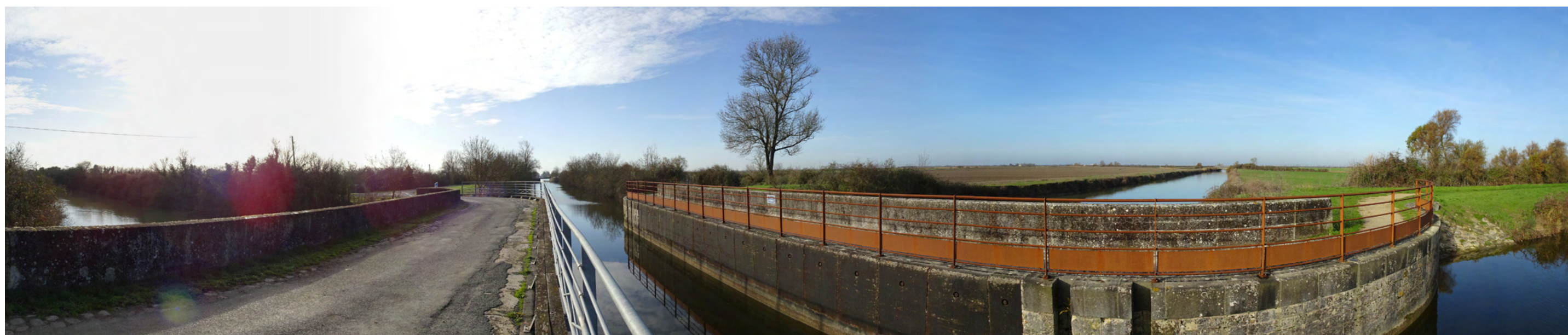
Photo 52 : Depuis le canal de Marans à La Rochelle les perceptions visuelles sont réduites et cadrées par la végétation qui borde l'infrastructure hydraulique en direction du site d'implantation potentiel
