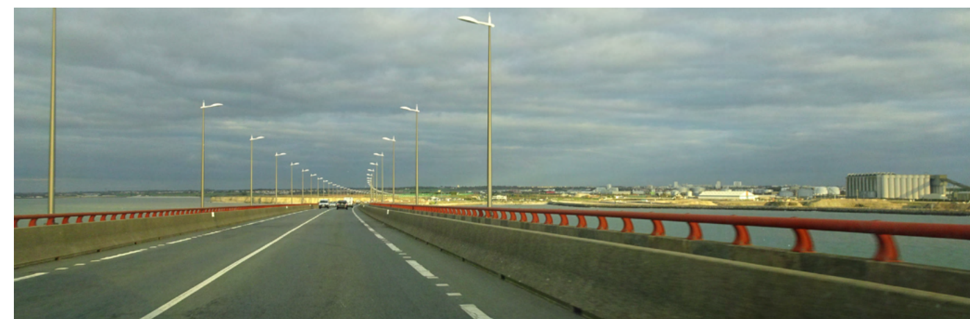
Photo 36 : Vue tronquée par les constructions sur le continent en direction du projet depuis le pont de Ré
