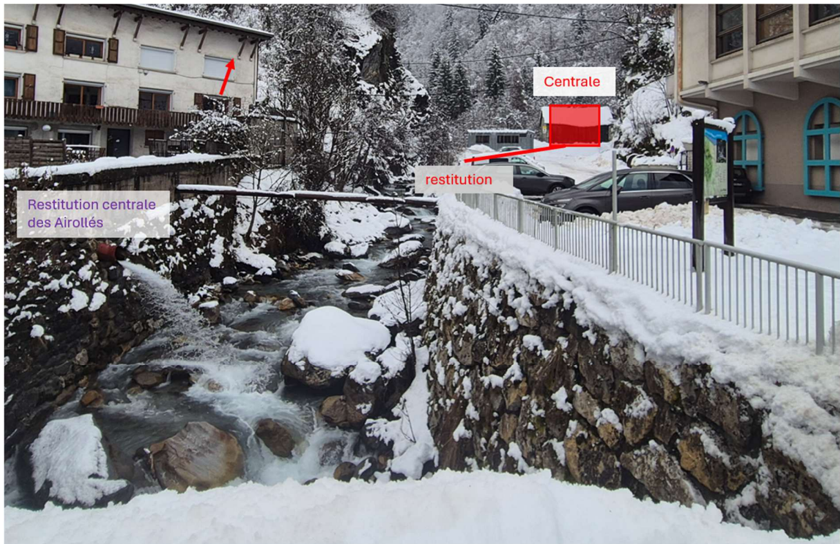
Figure 8: photographie de la zone de restitution
