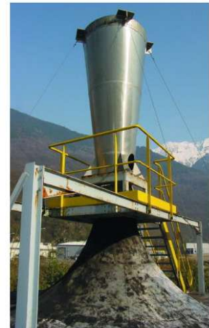
Prototype de tour solaire à Vortex réalisé par Sumatel
