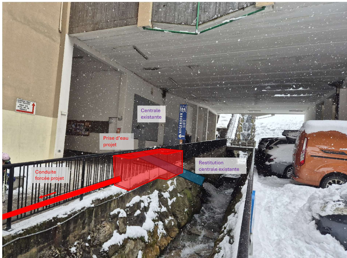
Figure 21 : Implantation de la prise d'eau
