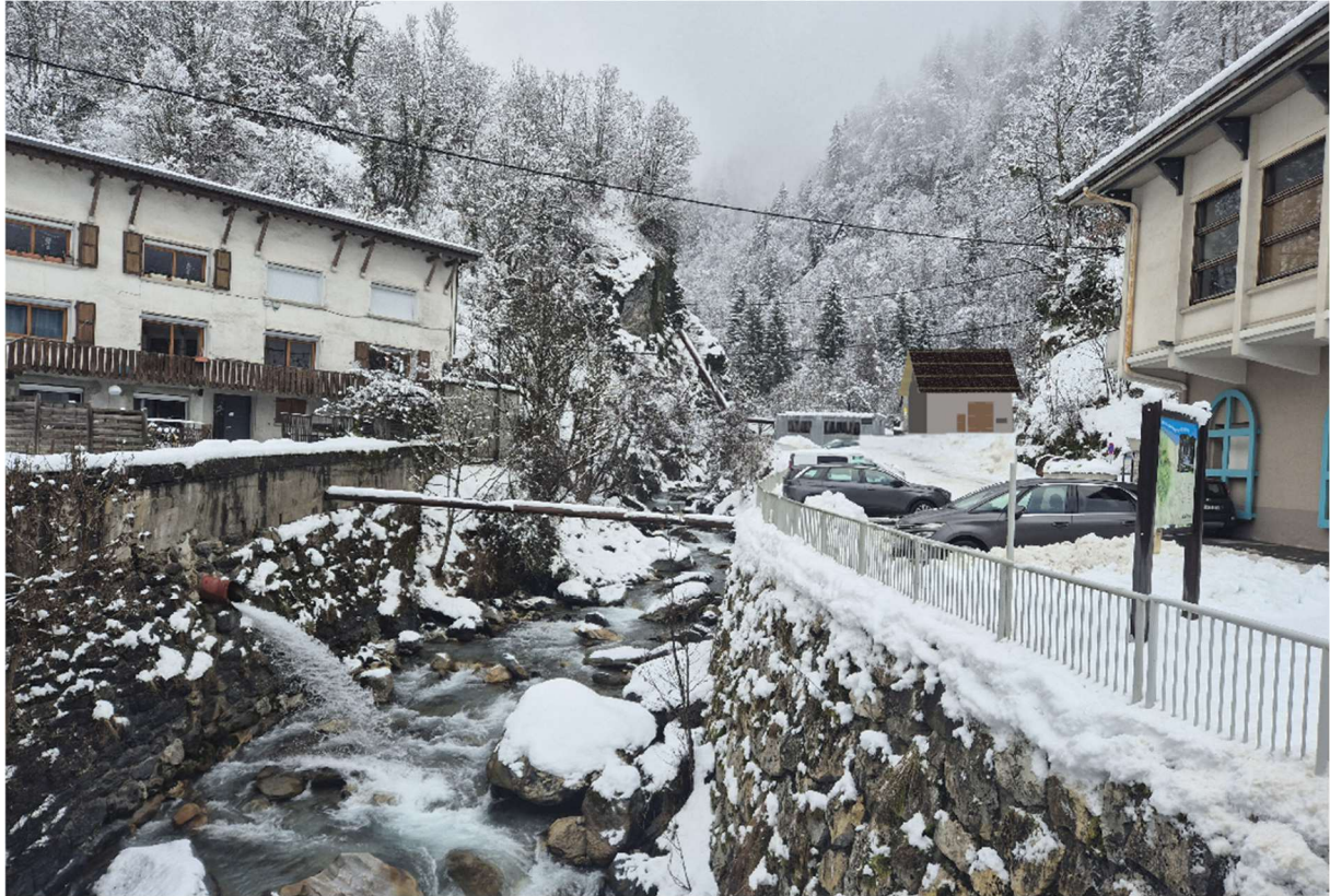
Figure 6 : vue de la traversée aérienne de la canalisation, en amont immédiat de la centrale. Cumul des incidences avec d'autres projets existants ou approuvés
