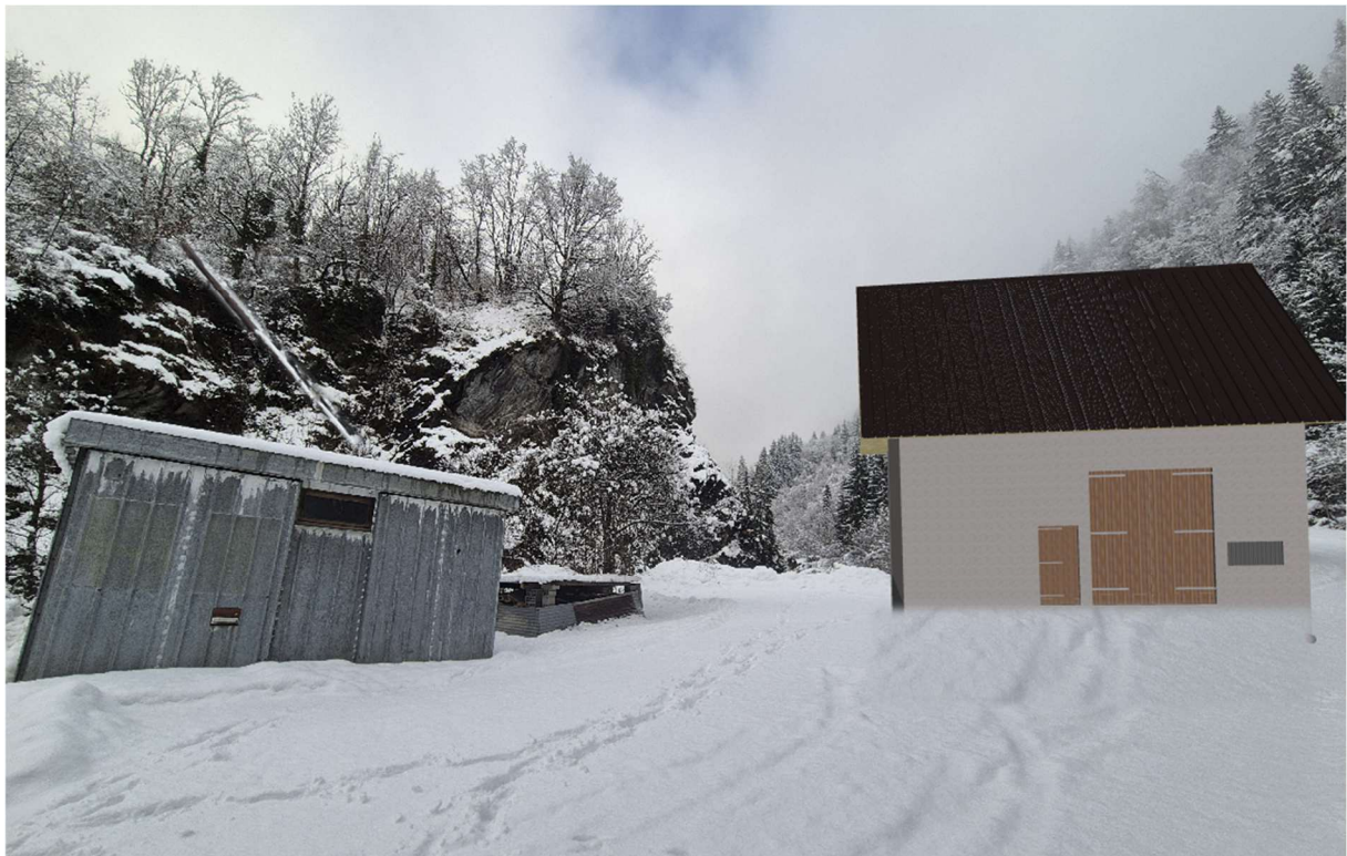
Figure 5 : vue de la centrale depuis le parking qu'elle borde
