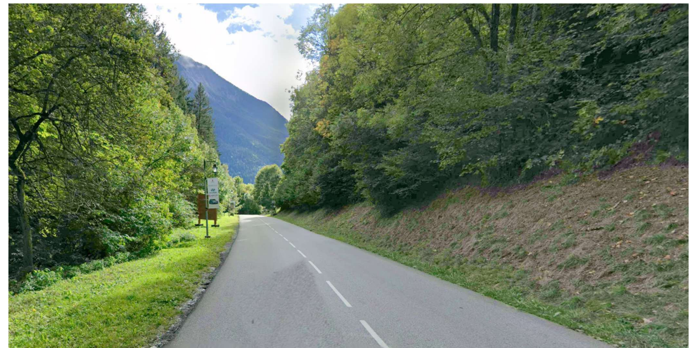
Figure 89: Vue de la partie centrale du tracé, où la conduite sera enterrée sous la route ou en accotement
