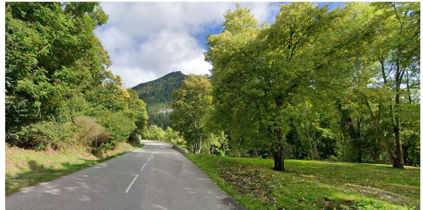
Figure 88 : Vue de la partie centrale du tracé, où la conduite quitte la RD91B
