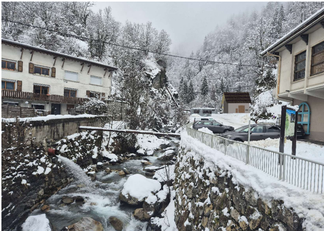
Figure 91 : vue depuis la RD 915, après travaux
