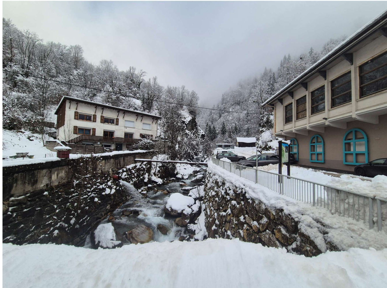
Figure 9 : Photo en aval, vers la centrale
