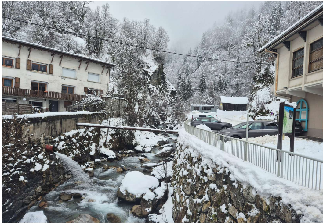
Figure 90: vue depuis la RD 915, avant travaux
