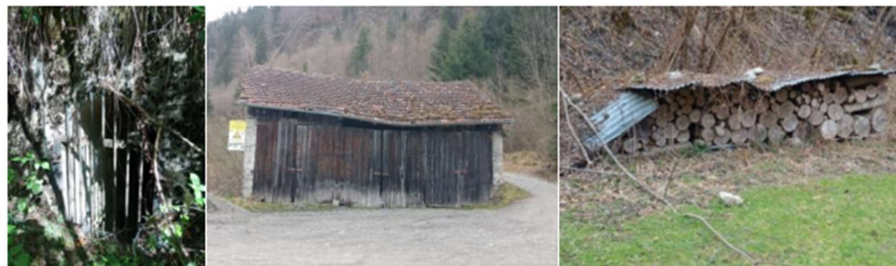
Figure 56 : Conduite (C-1) équipée de dispositifs acoustique et photographie, ancienne grange (G-1) et dépôts de bois (B-1)
