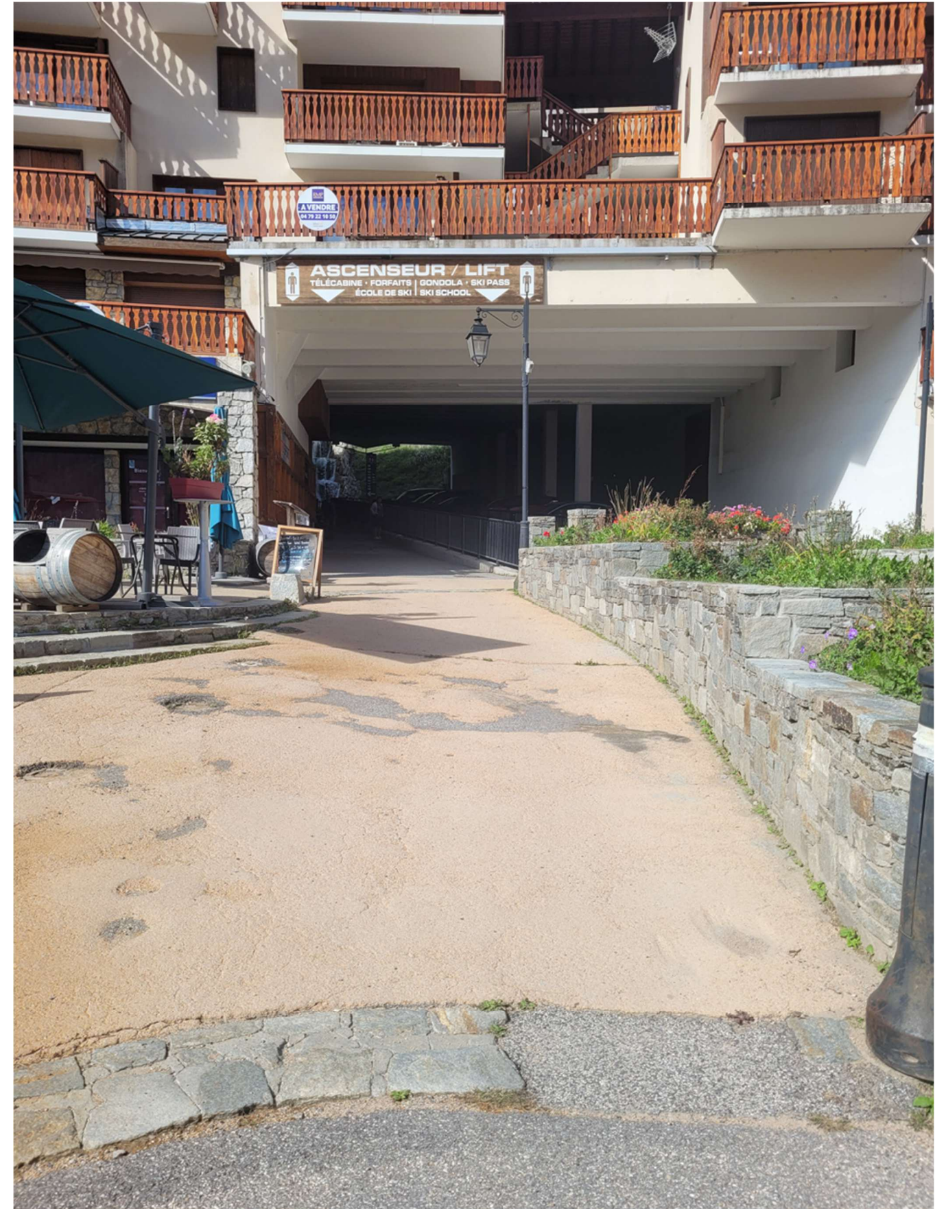
Figure 8 : Aperçu de la résidence de tourisme au dessus du captage
