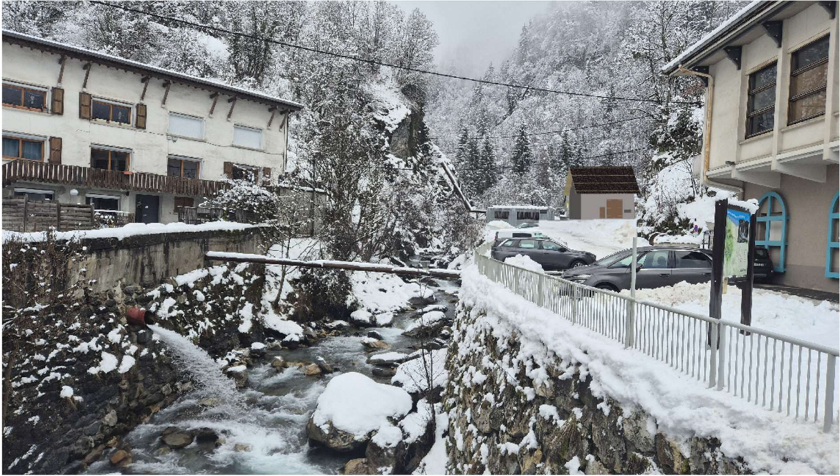
Figure 18: centrale et conduite vue du pont de la RD915
