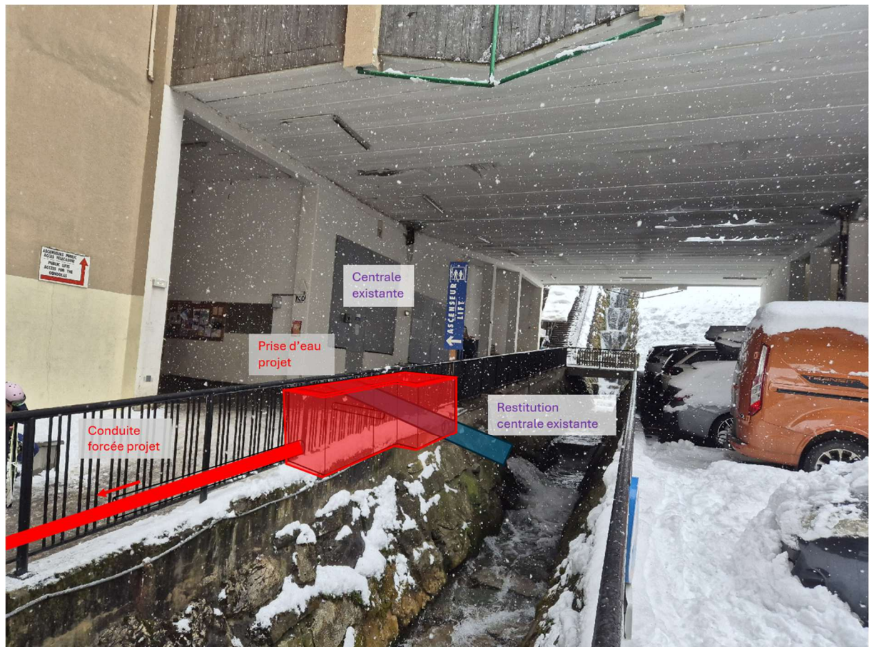
Figure 6: insertion 3D de la prise d'eau, vue depuis rive gauche
