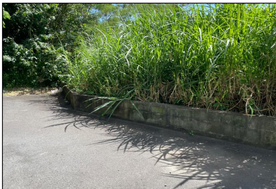
Figure 26 : Muret entourant la parcelle – face ouest
