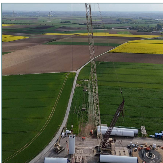
FIGURE 19: Levage de la première section
