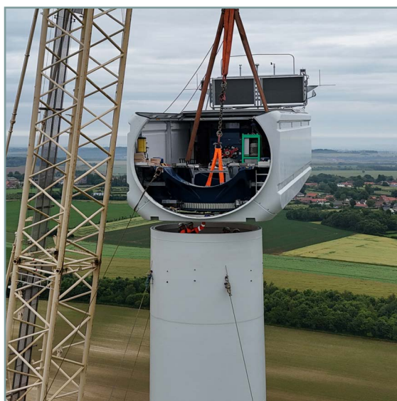
FIGURE 20: Levage de la nacelle
