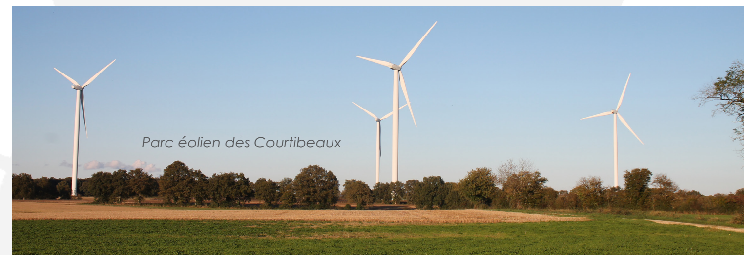
Parc éolien des Courtibeaux, à proximité de la zone de projet la base des éoliennes est masquée
