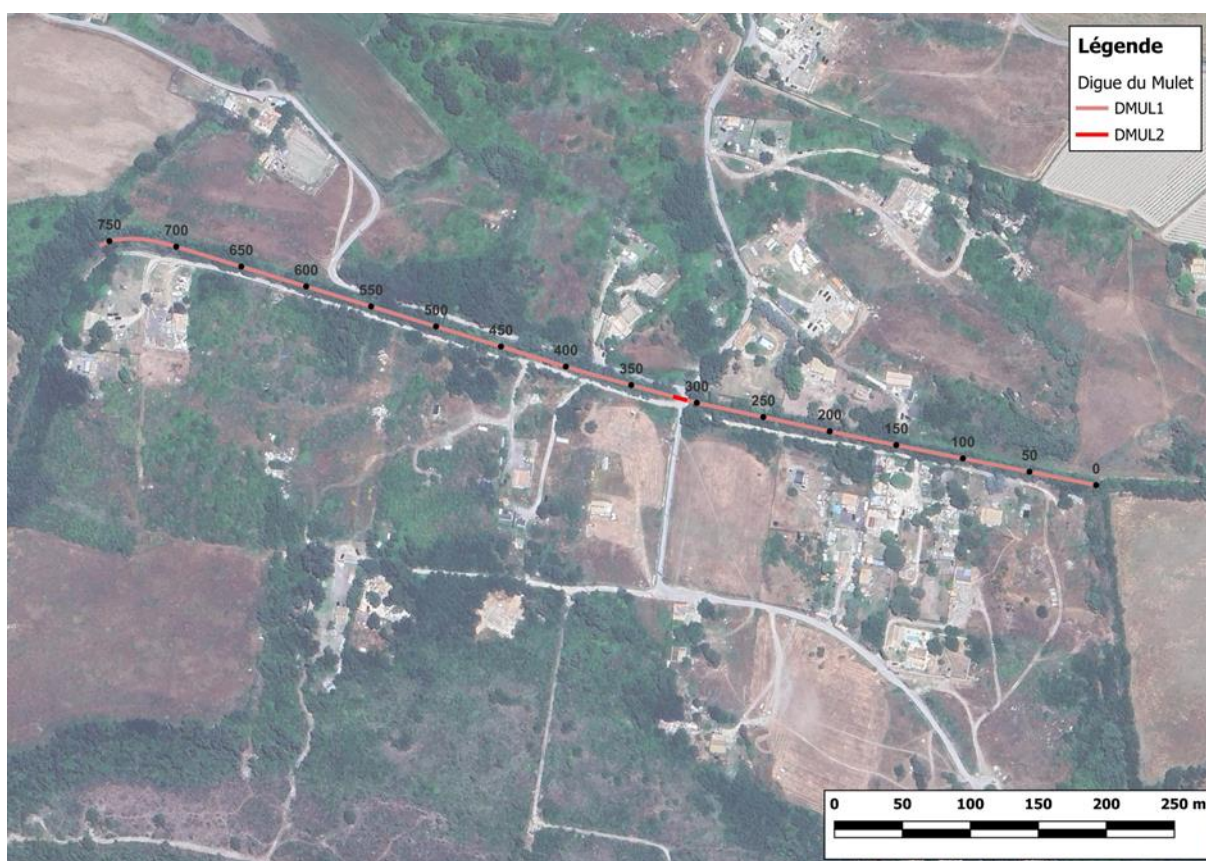
Figure 105 : Digue du Mulet – Tronçons homogènes
