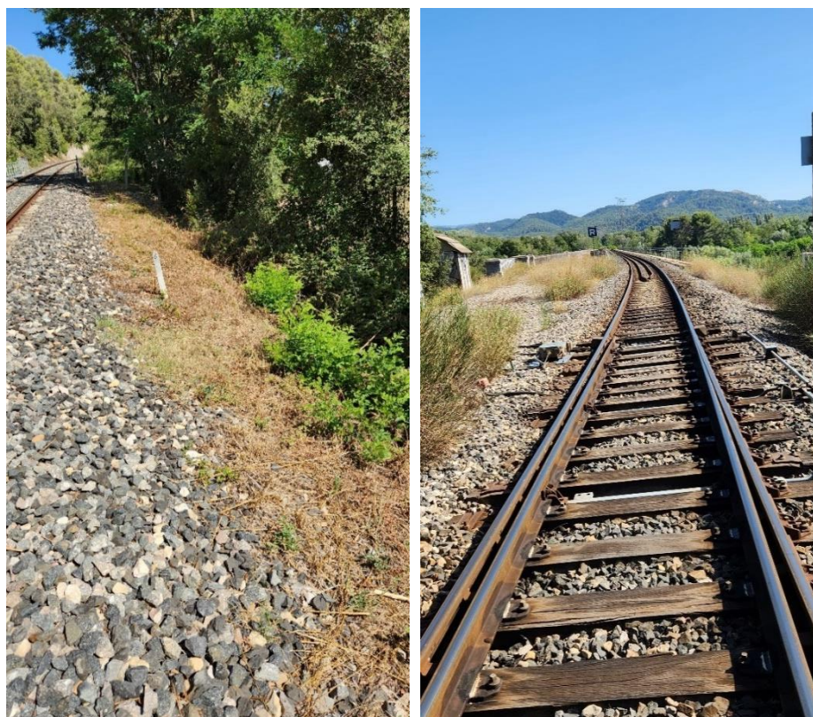
Figure 136 : Végétation (sur les talus) et voie ferrée (en crête) du remblai de la voie ferrée (source : Antea Group, 2024)
