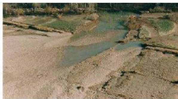
Figure 127 : Rupture de l'épi du Piquet (Charleval, 13)
