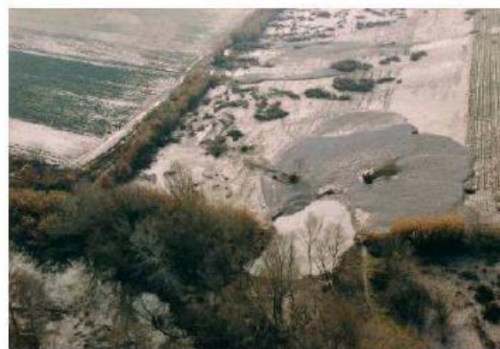
Figure 128 : Rupture de l'épi des Vanades (La Roque d'Antheron, 13)
