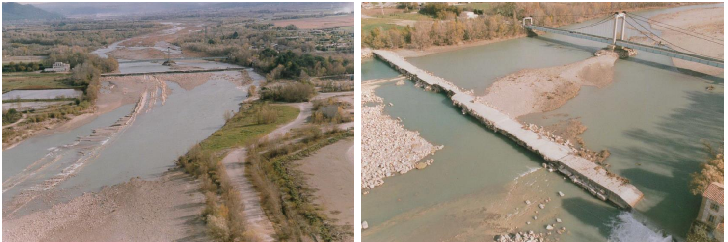
Figure 62 : Photographies aériennes du pont de Pertuis et du seuil du canal de Marseille prises à la suite des crues de 1994 (source : SMAVD)
