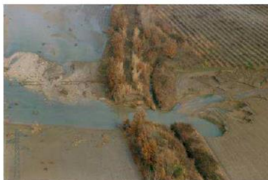
Figure 126 : Rupture de l'épi des Bergers d'Arles (Le Puy Sainte-Réparate, 13)
