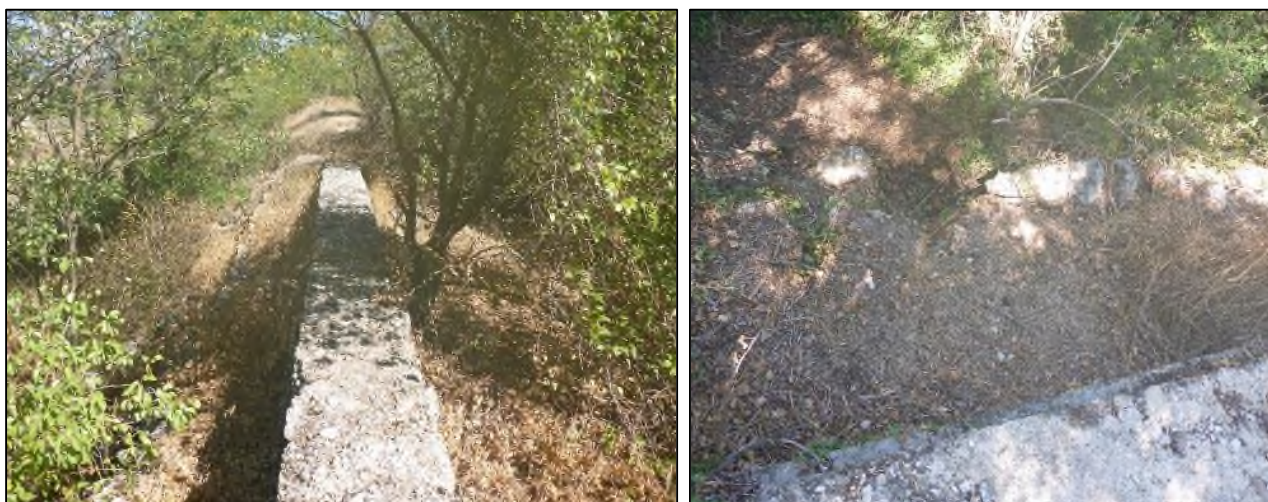
Talus aval en enrochement libre et muret en béton en crête (à gauche et à droite)
