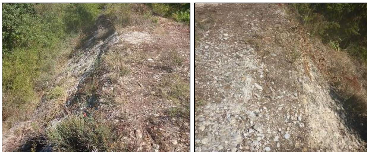
Talus avec perré en béton (à gauche et à droite)
