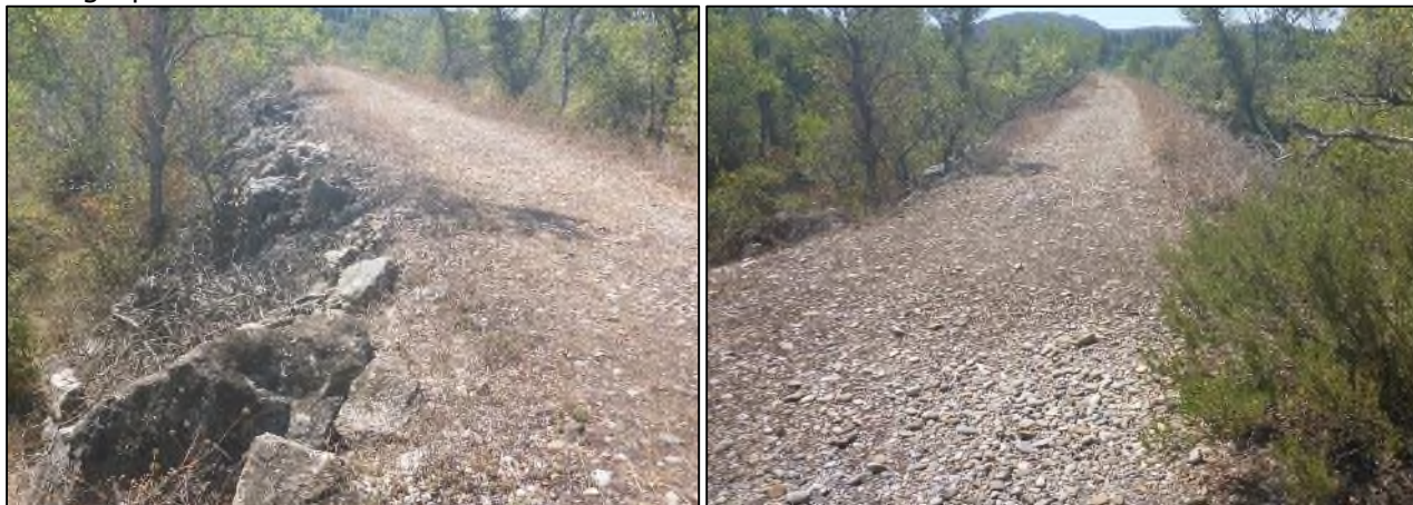
Talus en enrochements libres (à gauche) et crête de digue (à droite)
