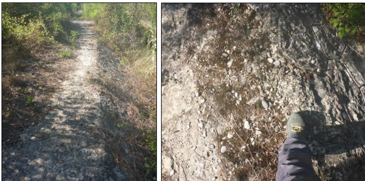
Crête et talus de digue avec dallage en pierres jointoyées (à gauche et à droite)
