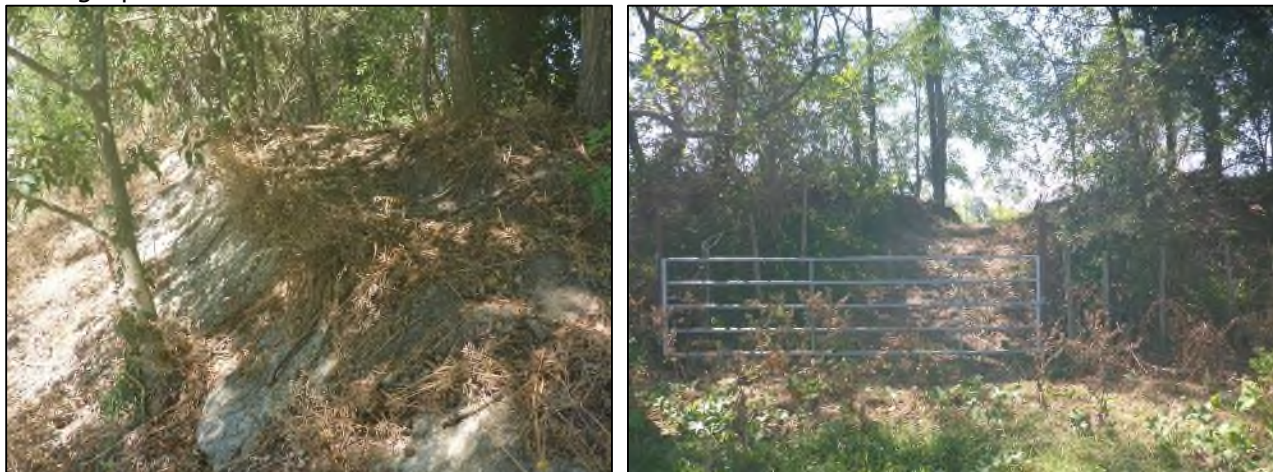
Talus avec perré en béton côté rivière (à gauche) et talus végétalisé côté terre (à droite)
