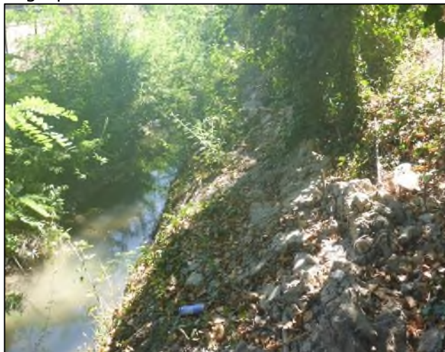
Talus côté terre avec fossé en pied avec (à gauche) et talus végétalisé côté rivière (à droite)
