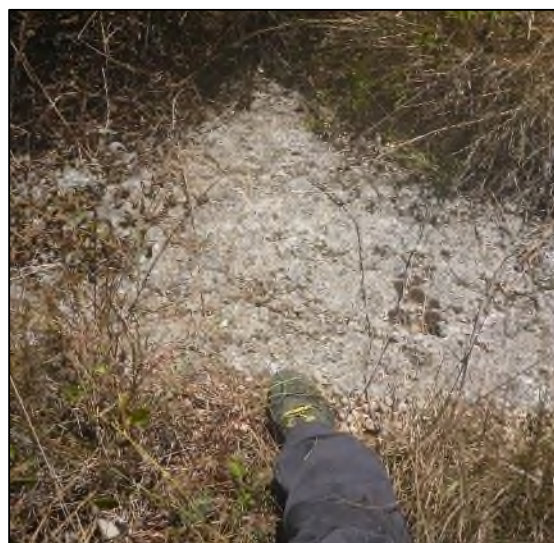
Talus amont avec perré en béton grossier (à gauche et à droite)
