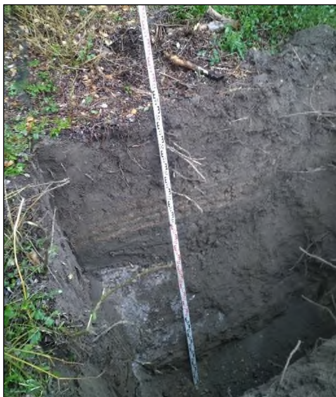
Vue de la base du perré béton dans le sondage PM31B
