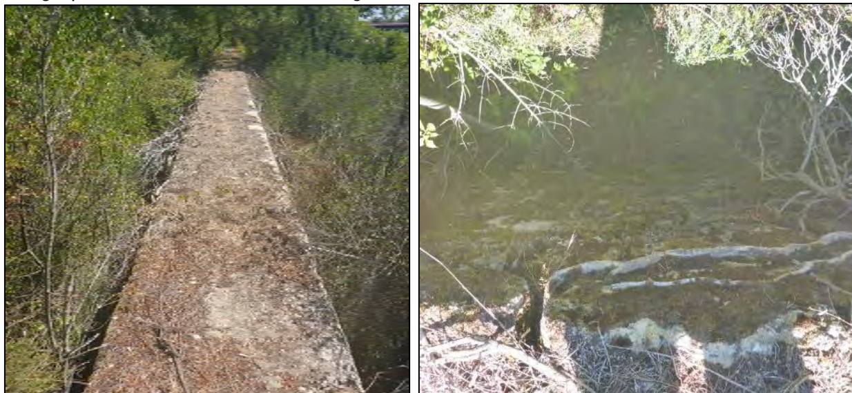
Tête du mur en pierre (à gauche) et parement du mur (à droite)
