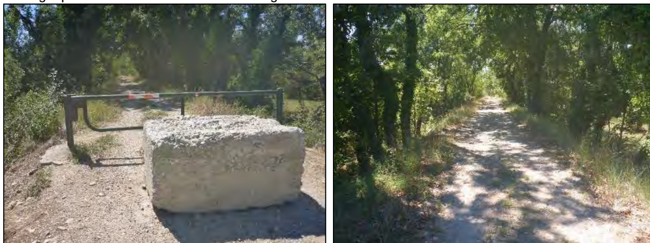
Tête de digue avec talus fortement boisé (à gauche et à droite)
