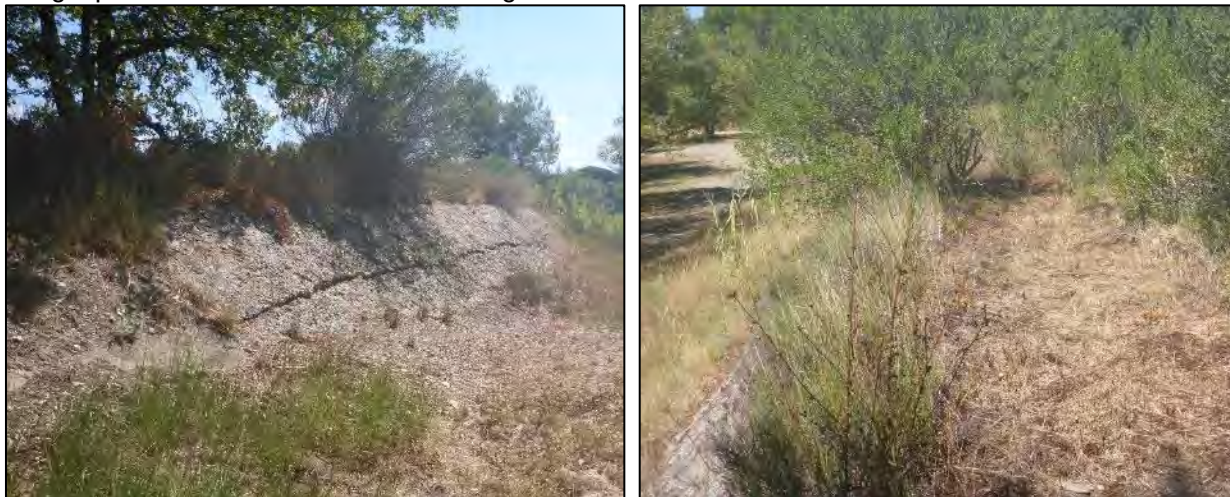
Talus avec perré en béton côté rivière (à gauche) tête de digue (à droite)
