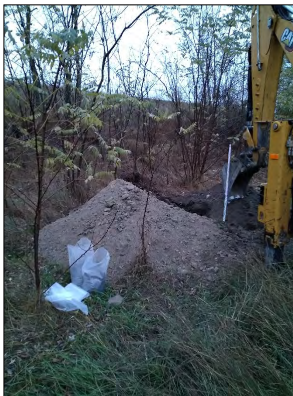
Photographies du sondage à la pelle PM11
