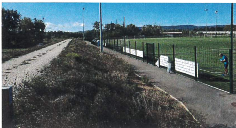
Photographie de la digue actuelle au droit du projet
