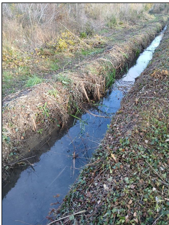
11. Canal nettoyé du côté Est de la digue de Mulet.
