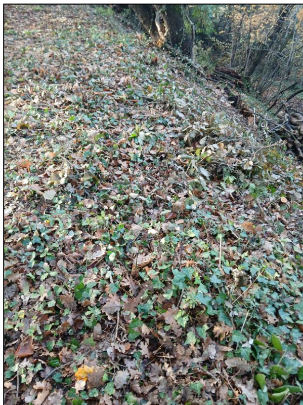
8. Hauteur de débroussaillage conforme sur la digue de Tarteau.
