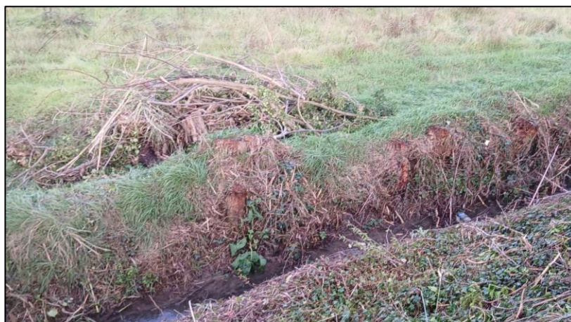
13. Canal du côté Ouest de la digue de Mulet.
