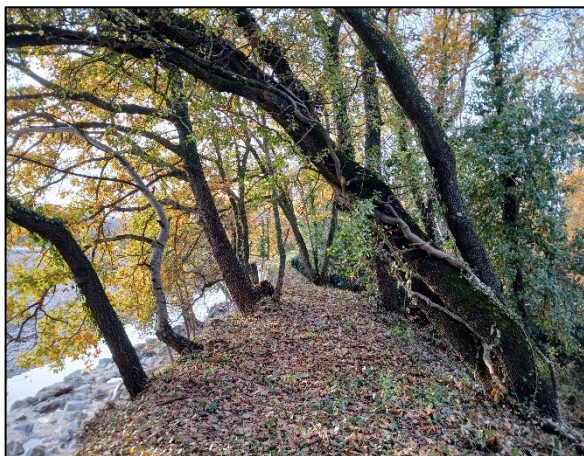
1. Continuité préservée sur la digue de Tarteau.
