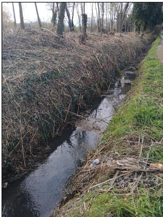
12. Canal jouxtant la partie centrale de la digue de Mulet.
