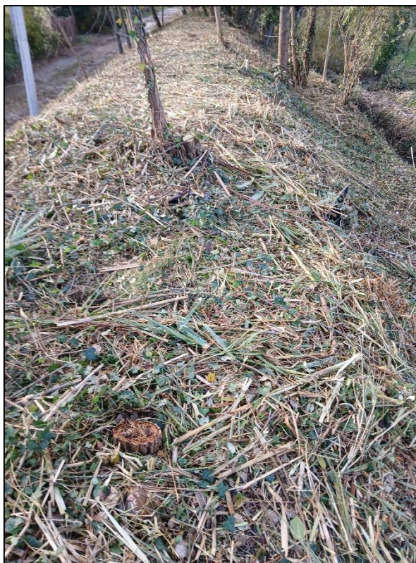
7. Secteur où la hauteur de débroussaillage n'a pas été respectée sur la digue de Mulet.
