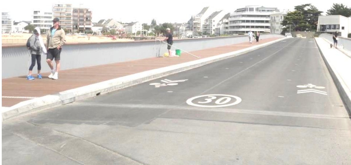
PHOTOGRAPHIE DU VIADUC DE PORNICHET – SOURCE ACTU.FR
