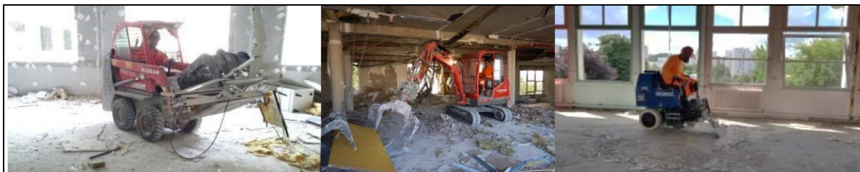
Figure 39 : Variantes de curage mécanique à l'aide d'engins adaptés
