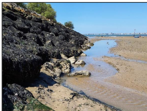
Figure 143 – Illustration des ceintures algales couvrant les enrochements du terre-plein actuel
