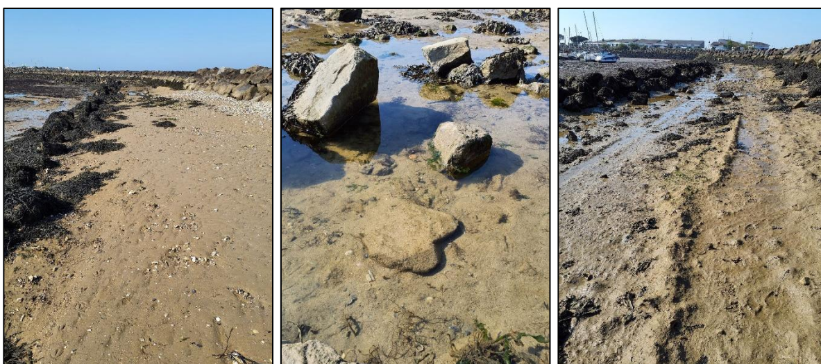
Figure 120 – Illustration de la nature superficielle des fonds sur l'emprise de la « piste » intérieure de la digue nord
