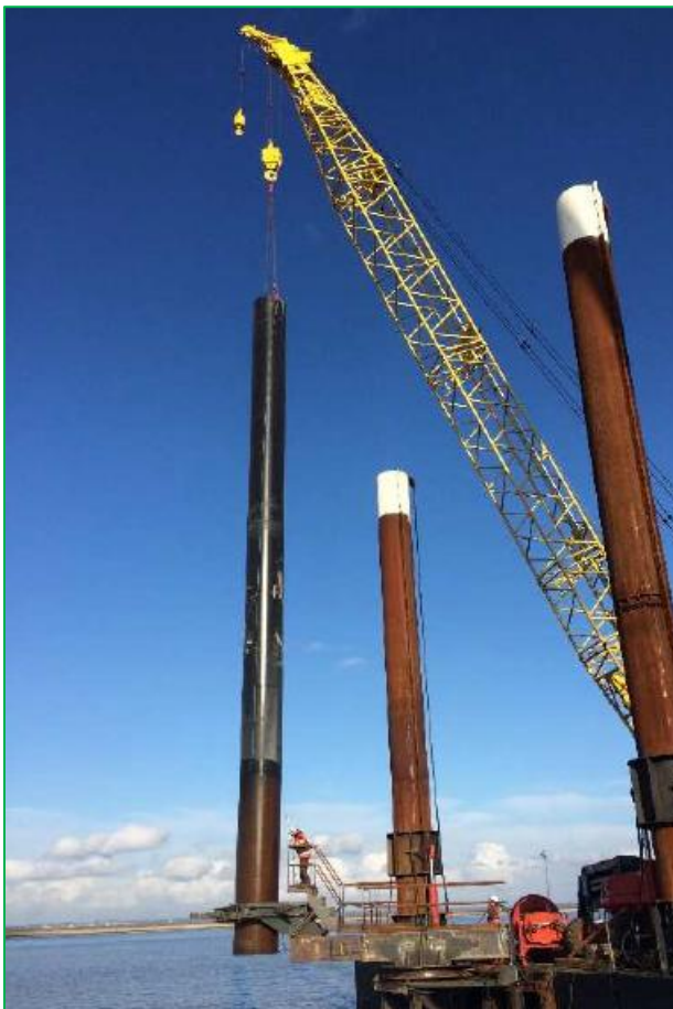
Positionnement du pieux avant battage
