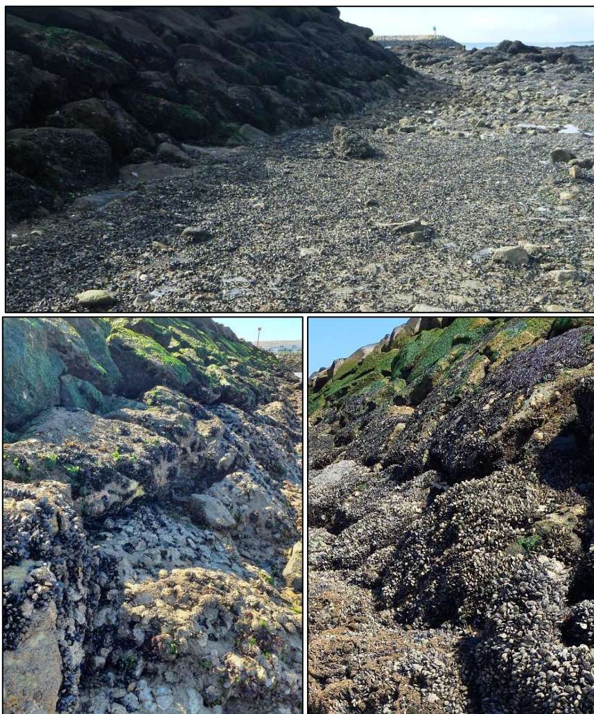
Figure 150 – Moulières médiolittorales au sol (photo du haut) et colonisant une partie des enrochements extérieurs de la digue actuelle (les deux photos en bas)
