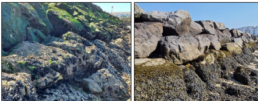
Figure 148 – Expression des algues opportunistes (algues vertes) sur la digue actuelle (photo de gauche) et de la ceinture à F. vesiculosus discontinue sur la face interne de l'ouvrage et la piste intérieure (photo de droite)
