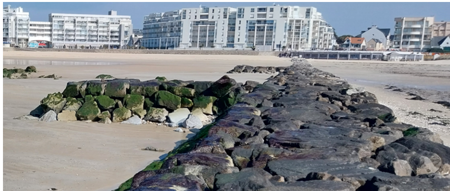
Figure 19 : Épis conservés dans le projet de rénovation de la digue
