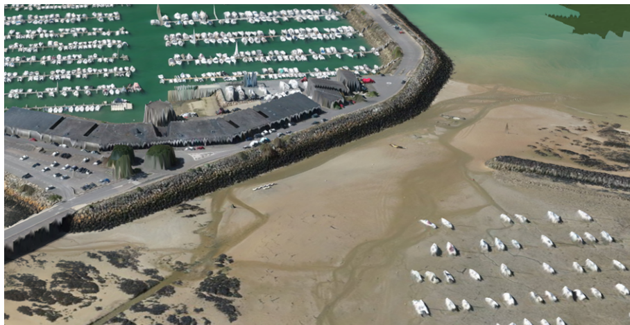
Figure 29 : Vue du terre-plein actuel (Levé de drone)
