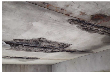
Figure 37 : Sous face du tablier
