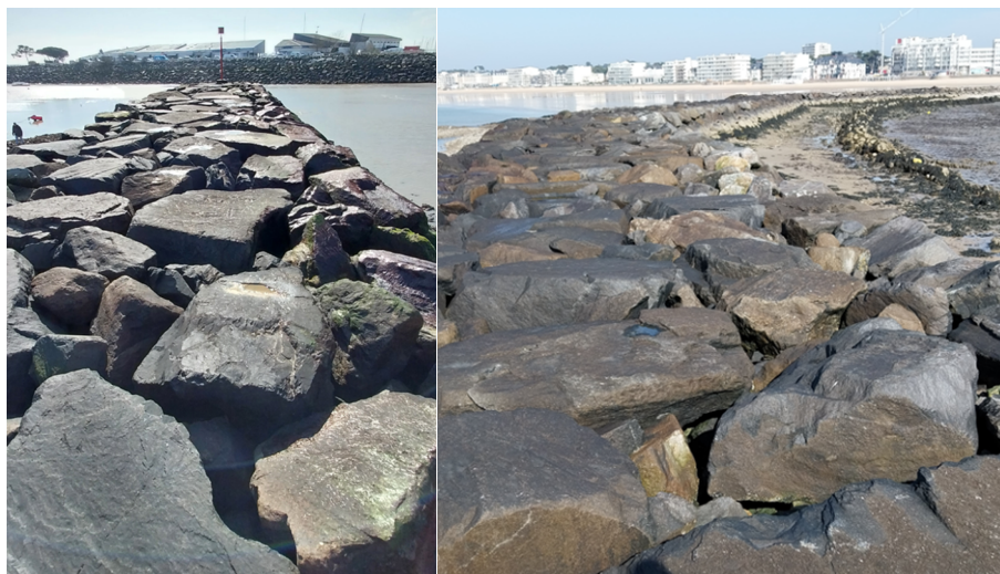
Figure 16 : Vue de la digue vers le Sud Figure 17 : Vue de la digue vers le Nord
