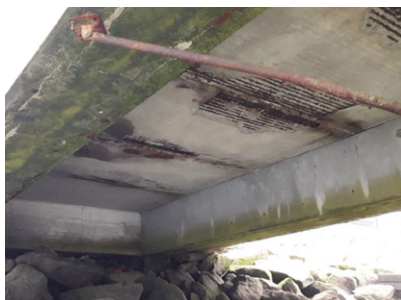
Figure 36 : Sous face du tablier
