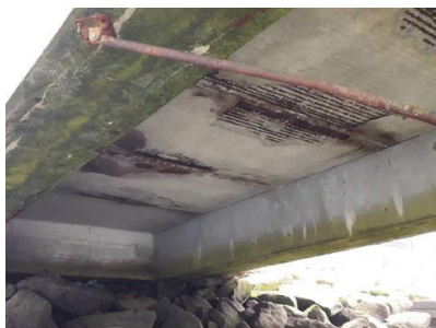
Figure 4 : Sous face du tablier
