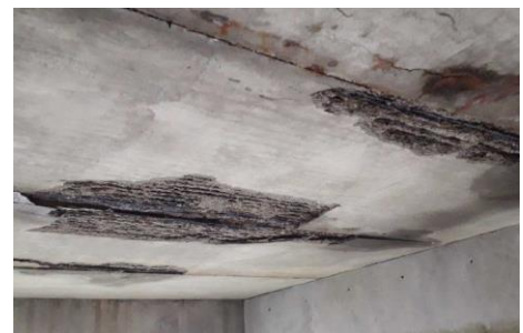
Figure 5 : Sous face du tablier
