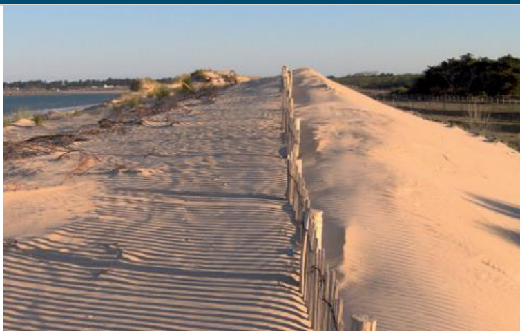
Photo 14 : Protection de brise-vent en ganivelle (@Guide de gestion des dunes et des plages associées, L. Gouguet)
