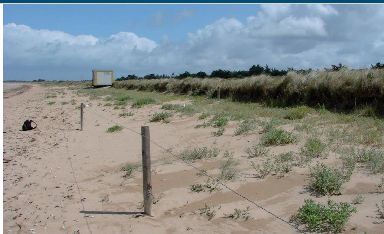
Photo 16 : Protection du pied de dune par un fil lisse (@Guide de gestion des dunes et des plages associées, L. Gouguet)
