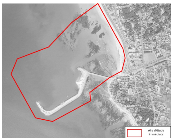
Figure 6-3 : Port de Pornichet lors de la construction de sa partie "plaisance" en 1977 - Source : IGN Remonter le temps
