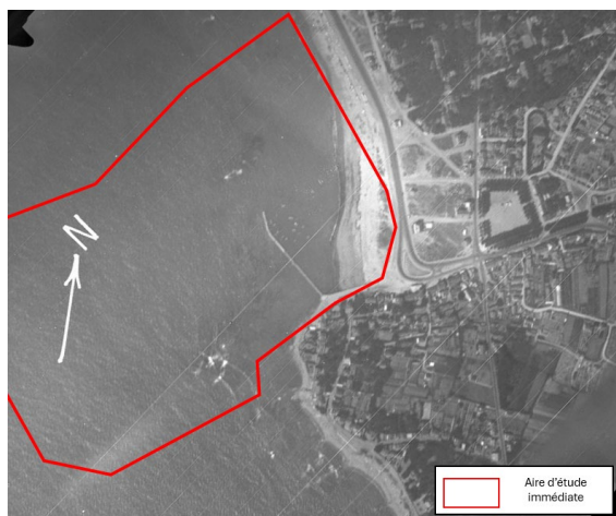
Figure 6-1 : Port de Pornichet en 1932 -Source : IGN Remonter le temps
