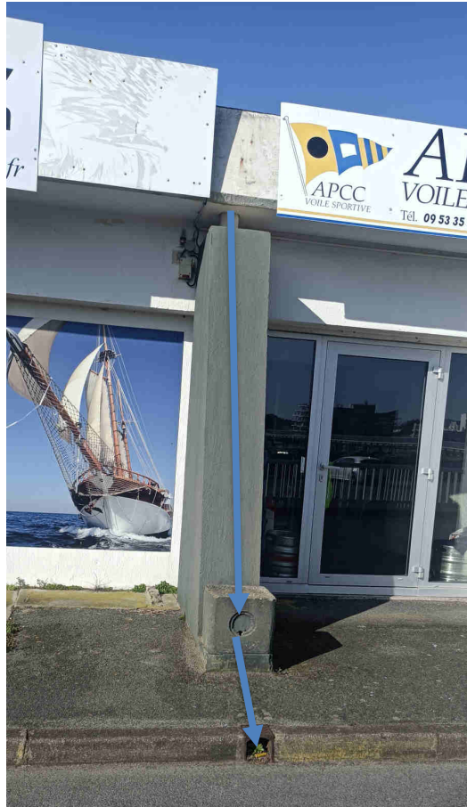
Exemple d'une descente EP de toiture
