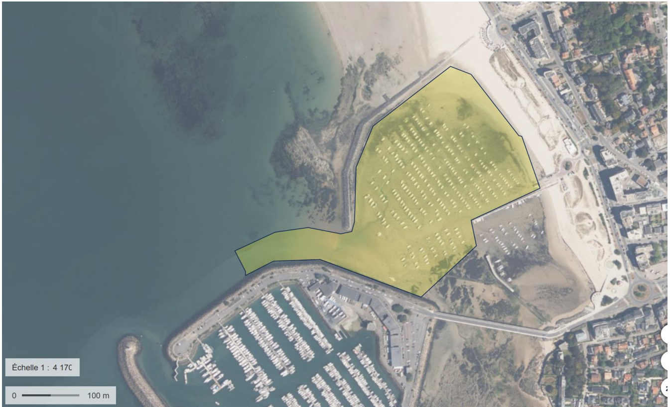
Figure 1 : Localisation sur une vue geoportail.fr de la zone d'étude, au port d'échouage de Pornichet
