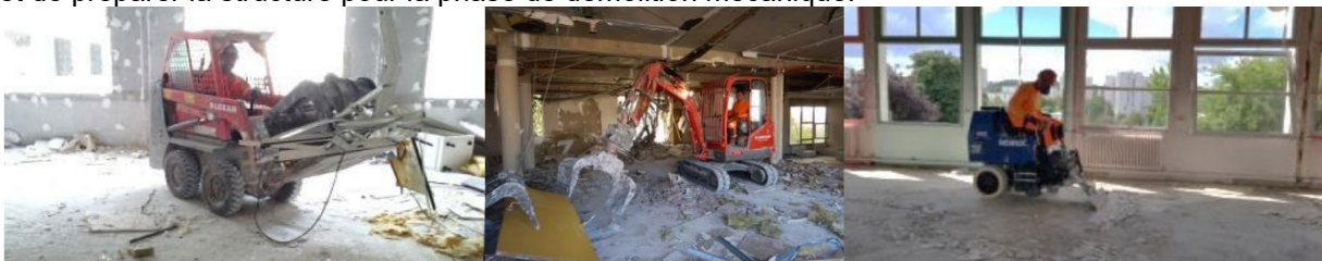
Figure 1-14 : Variantes de curage mécanique à l'aide d'engins adaptés
