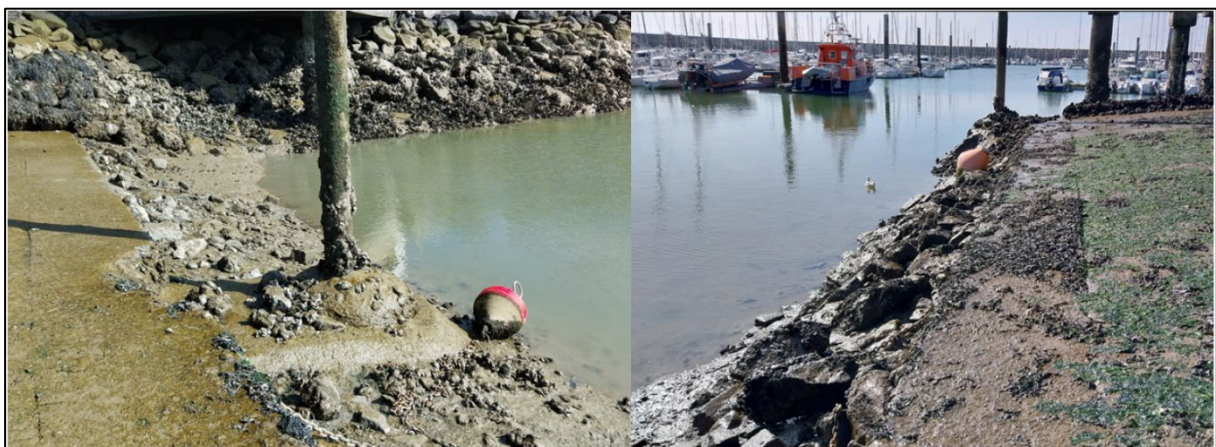
Figure 2-12 – Blocs et sédiments en pied de cale
