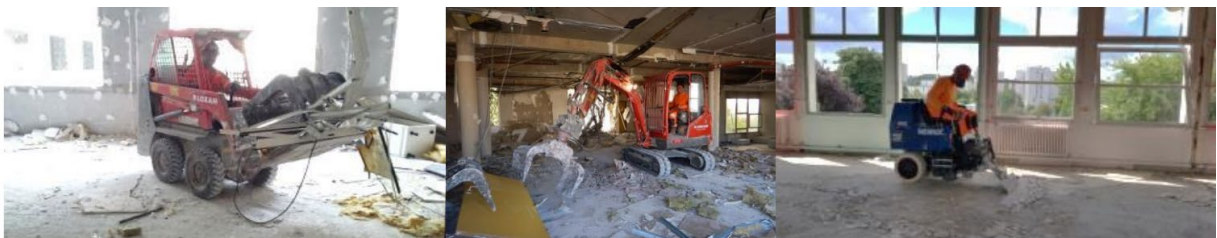
Figure 6-23 : Variantes de curage mécanique à l'aide d'engins adaptés
