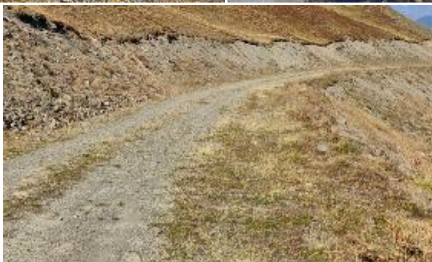
TERRASSEMENT G2 - VEGETATIONS HERBACEES ANTHROPIQUES (E5.1) A FAIBLE VALEUR PATRIMONIALE
