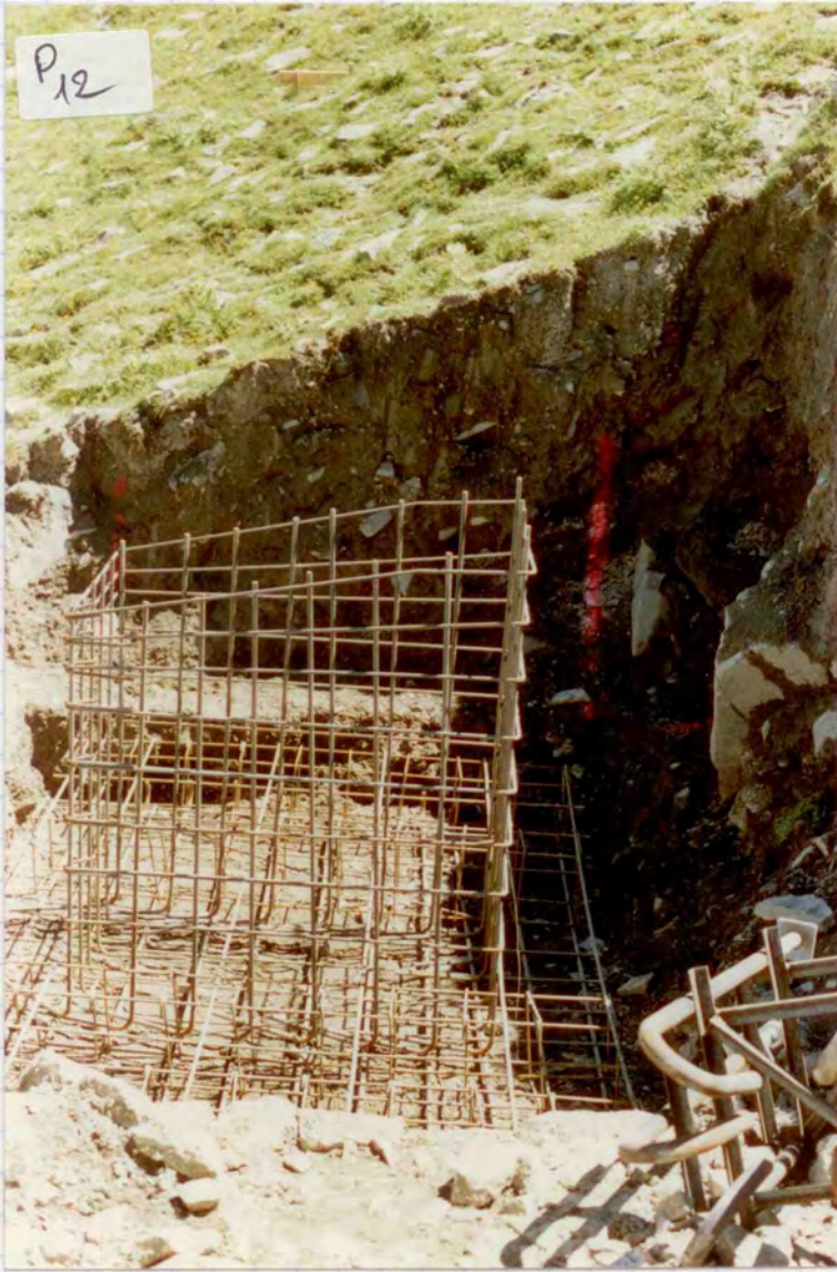
Eboulis rocheux en cours de consolidation moins aéré qu'en (11)
