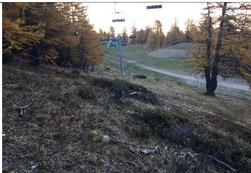
Figure 6 : photos de P1, P2 et de la gare aval
