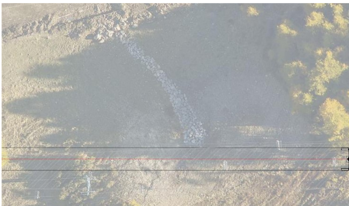
EXEMPLE DE ZONE INSTABLE AVEC DES TRAVAUX HYDRAULIQUE DE CONFORTEMENT DANS LES PENTES IMPORTANTES À PROXIMITÉ DU DÉPART
