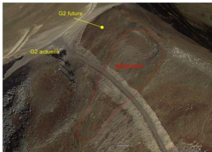
PHOTOGRAPHIES DU GLISSEMENT DE TERRAIN AU DROIT DE L'ARRIVÉE
