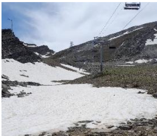
PHOTO PRISE SUR SITE LE 18 JUI 2024 A 2200 M.
